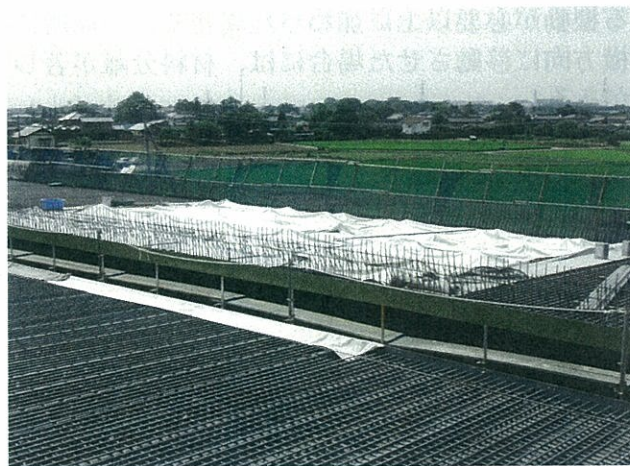
写-9.3.1 鋼板の温度上昇抑制対策 (例)
