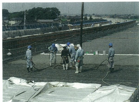
写-9.3.2 中央支間部からの打込み状況
