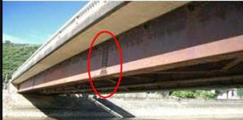
実腐食橋梁より切り出したパネル
