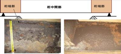
＜桁中間と桁端の腐食の違い(中桁)＞
