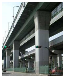
阪神高速道路の橋脚
