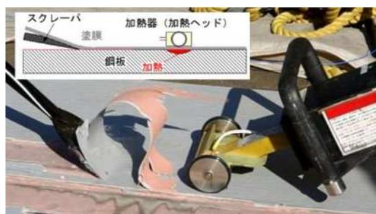
写真-4.2 電磁誘導 (IH) 工法による塗膜剥離状況
