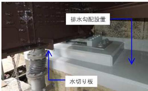
写真-5.42 橋台面排水勾配および水切り板の設置
