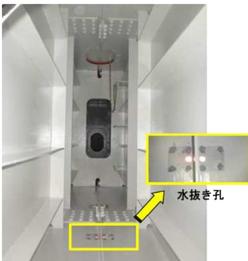
写真 - 5.14 主塔横梁の塗替えおよび水抜き孔の設置
