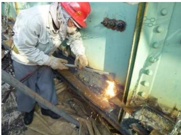
写真-5.24 腐食水平補強材切断撤去
