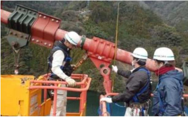
写真-5.12 ハンガーロープの取替状況
