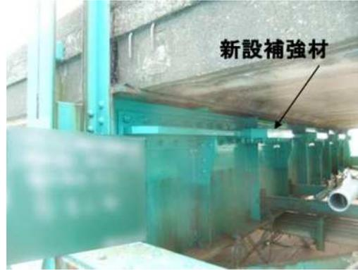
写真-5.20 補強完了
