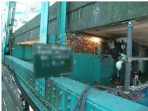
写真-5.18 垂直補剛材切断
