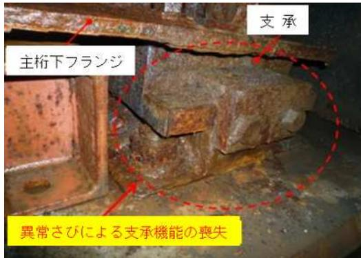
写真-5.32 支承部の腐食状況
