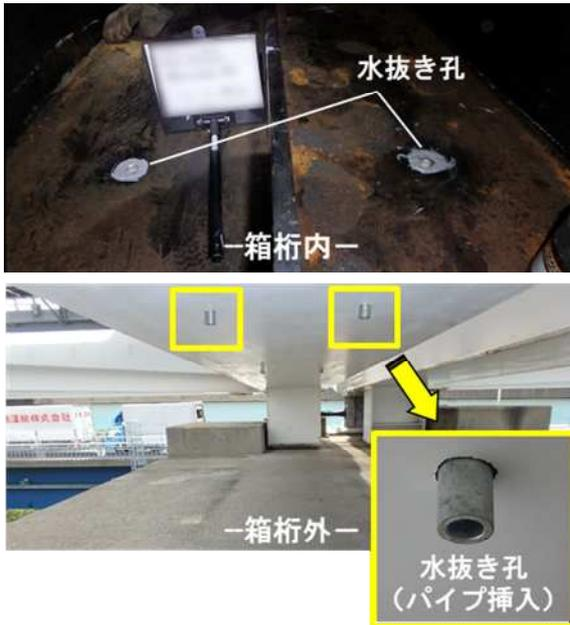
写真-3.2 下フランジへの水抜き孔設置例
