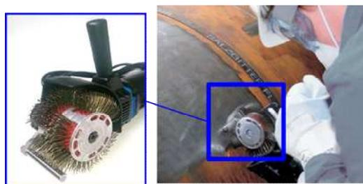
写真-4.3 ブリストルブラスターによる素地調整状況
