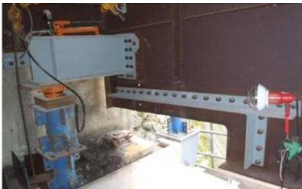
写真-5.38 支承撤去，主桁腐食部切断状況
