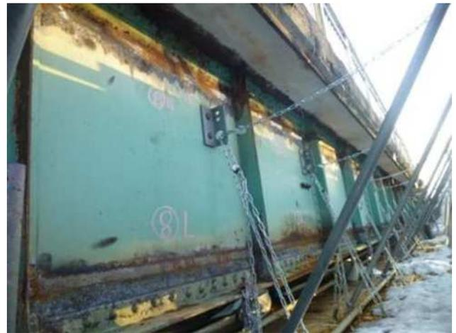
写真-5.25 水平補強材撤去完了
