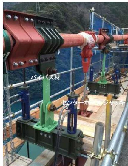
写真-5.11 バイパス材の設置状況
