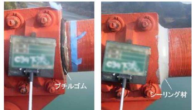
写真-5.6 ケーブルバンド部の防水処置
