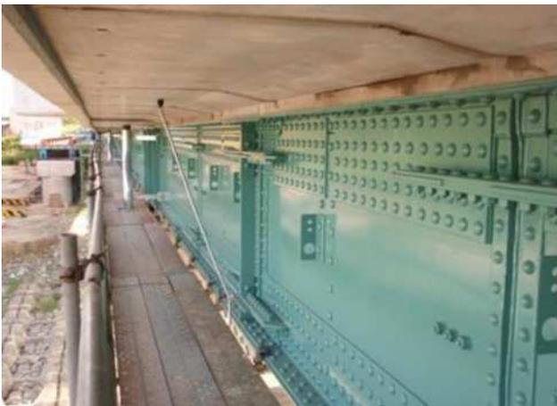
写真-5.29 現場塗装，補強完了
