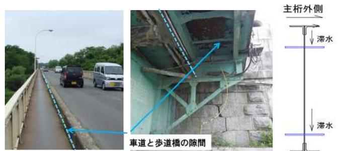
写真-5.22 車道と歩道の隙間からの漏水
