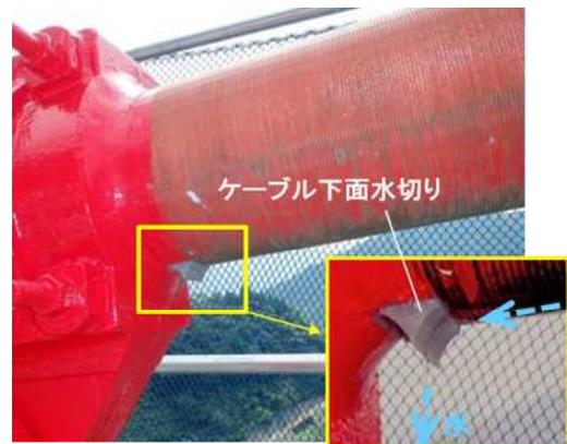
写真-5.7 ケーブル下面水切りの設置
