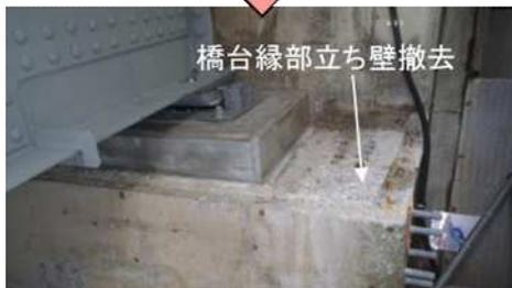
写真-5.41 橋台縁部立ち壁の撤去
