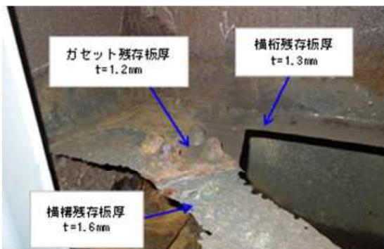
写真-5.33 横構の腐食状況
