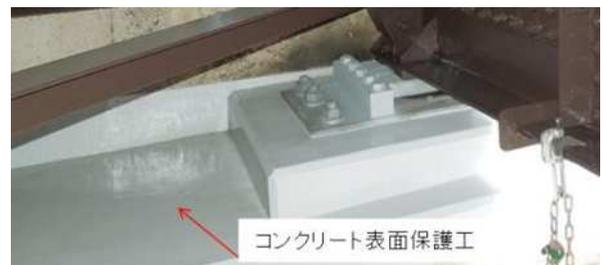
写真-5.40 コンクリート表面保護工
