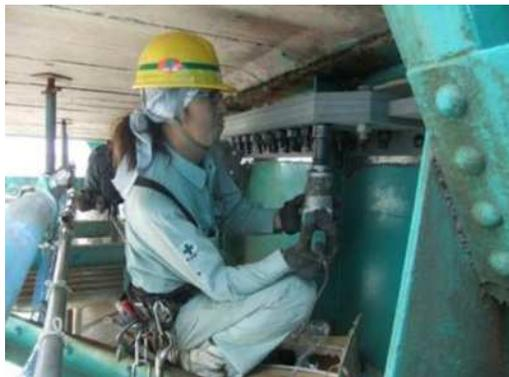
写真-5.19 部材取付，本締め
