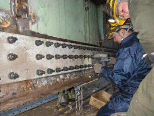
写真-5.28 当板取付け，ボルト締め
