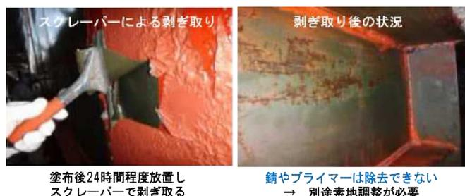
写真-4.1 剥離剤による塗膜剥離状況
