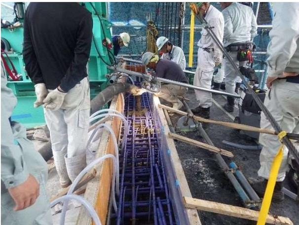
写真9 高流動コンクリート打設状況
