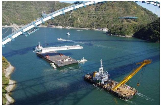
写真5 鋼補剛桁の直下吊架設状況
