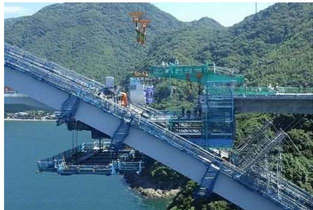
写真7 接合桁架設状況
