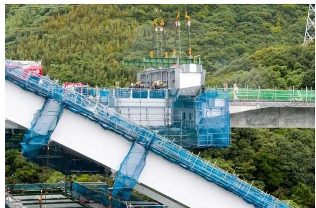
写真11 閉合桁の架設状況
