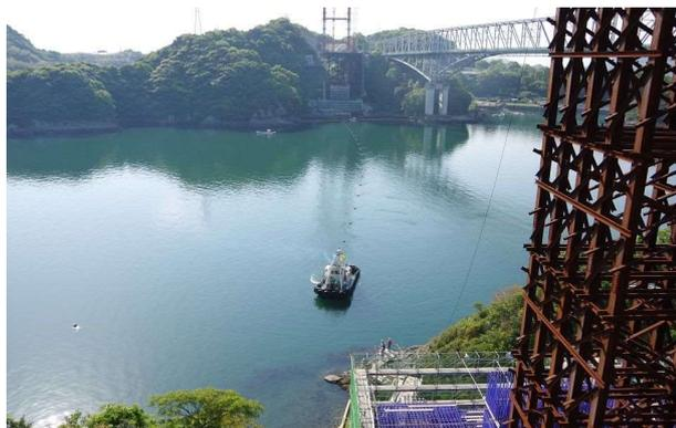
写真15 パイロットロープの施工状況
