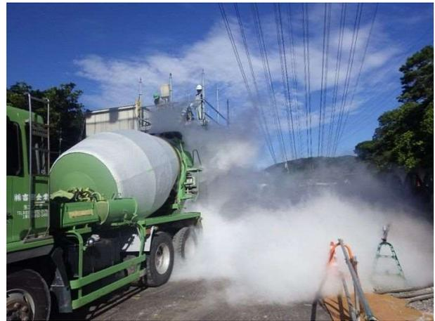
写真10 液体窒素の噴射状況
