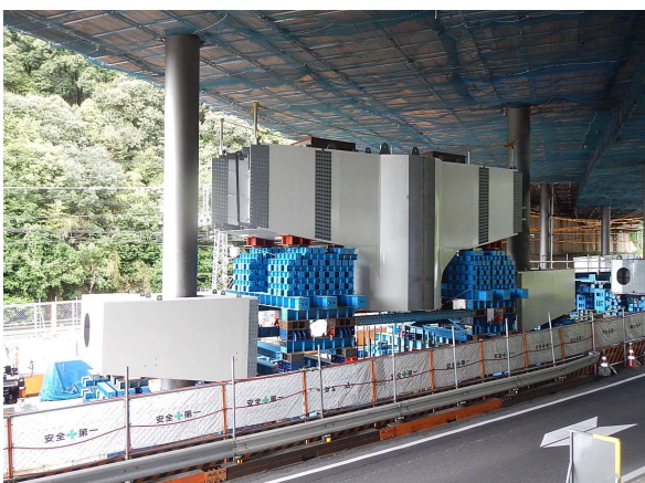
写真-8 鋼製梁部材（移動後）
