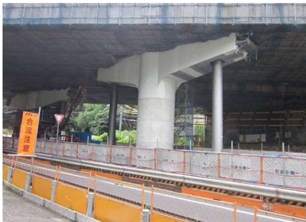
写真-11 新設橋脚完成
