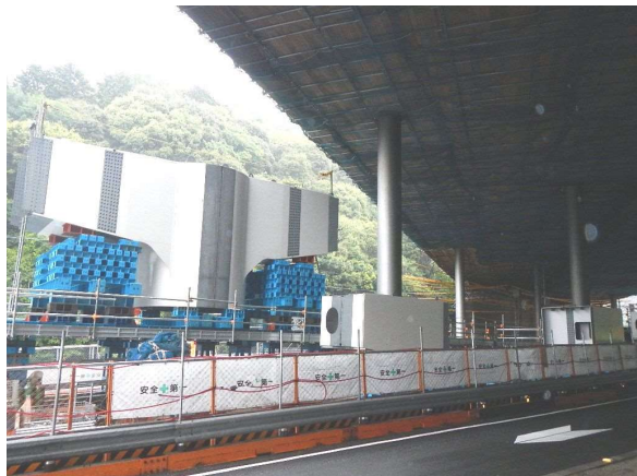
写真-7 鋼製梁部材（移動前）
