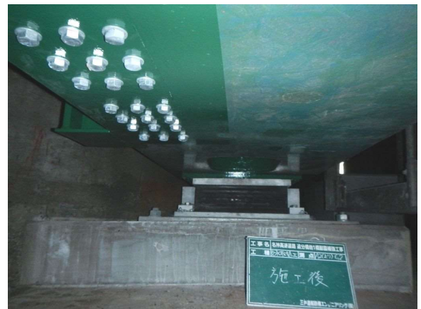
写真-16 端支点支承取り替え後
