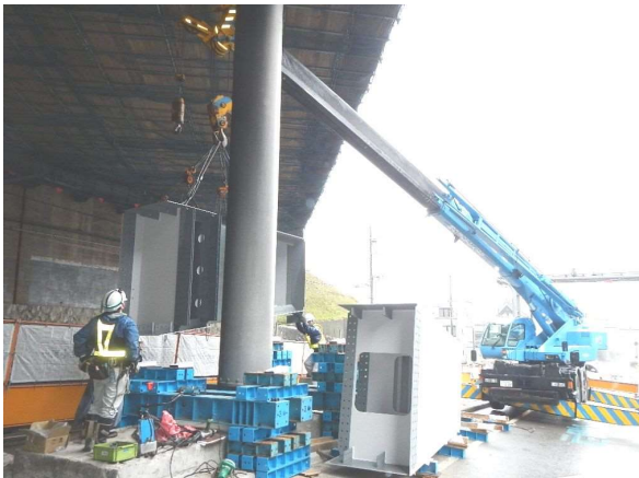
写真-6 貫通ブロック（鋼製梁先端部）架設
