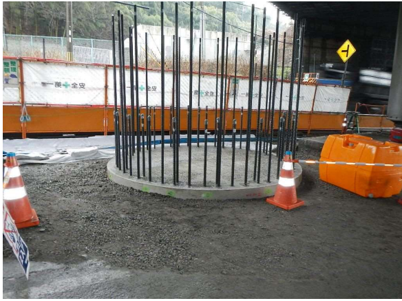
写真-5 基礎工及びRC柱1次施工完了
