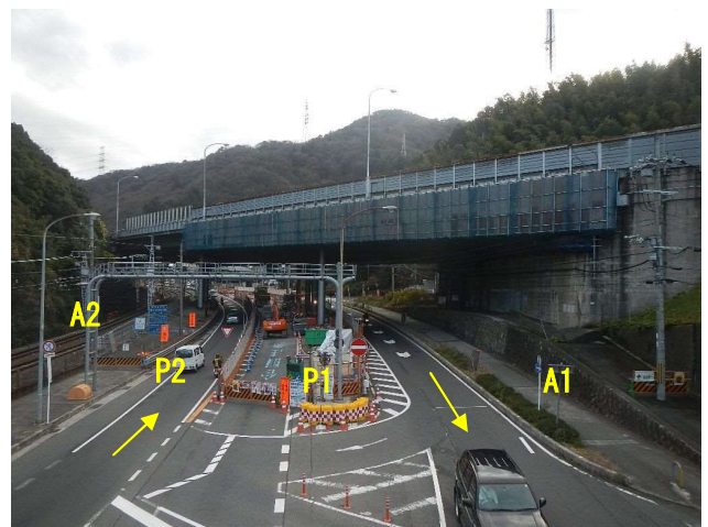
写真-3 P1 橋脚施工時状況
