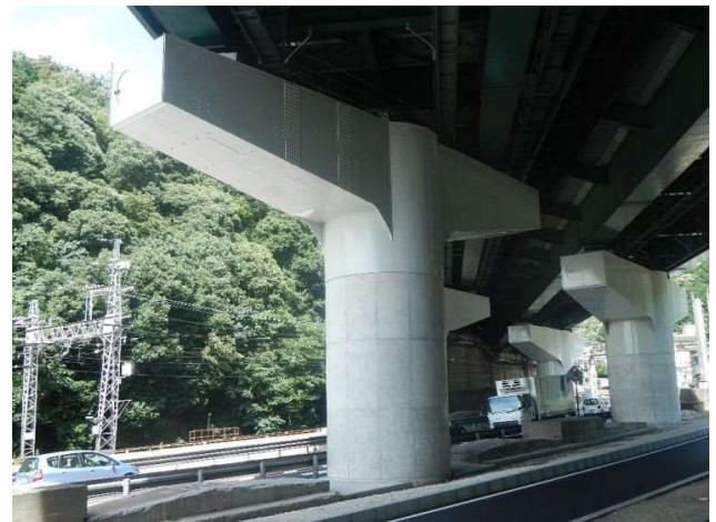
写真-2 追分橋（施工後）
