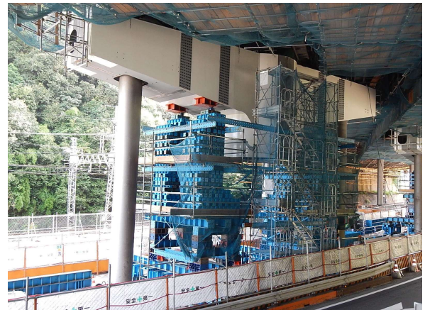
写真-10 鋼製梁ジャッキアップ
