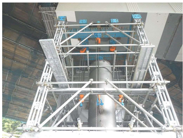
写真-13 既設ロッキング橋脚の支持
