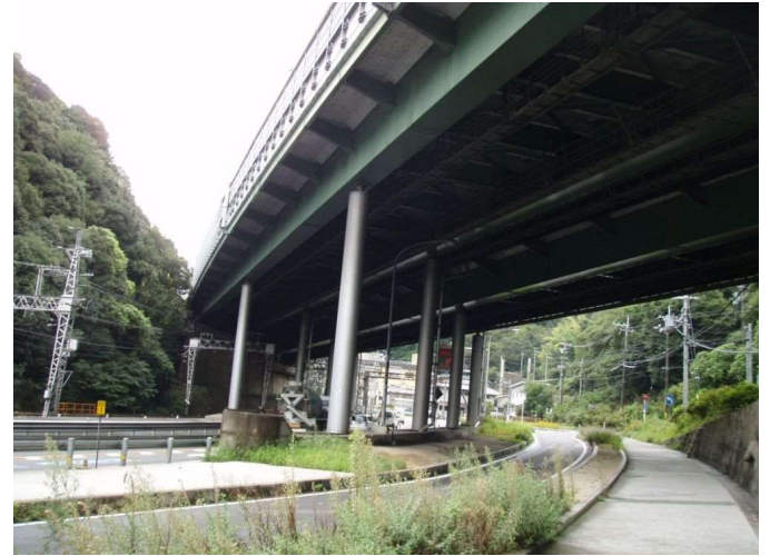
写真-1 追分橋（施工前）
