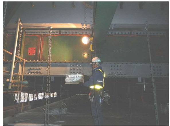
写真-14 横桁補強
