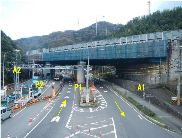
写真-4 P2 橋脚施工時状況
