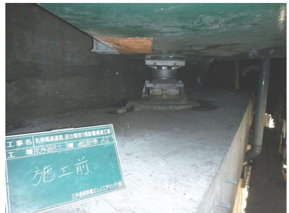
写真-15 端支点支承取り替え前
