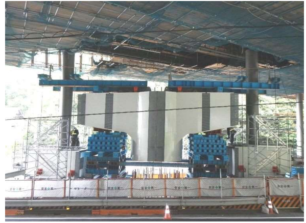
写真-9 鋼製梁一体化・吊上げ
