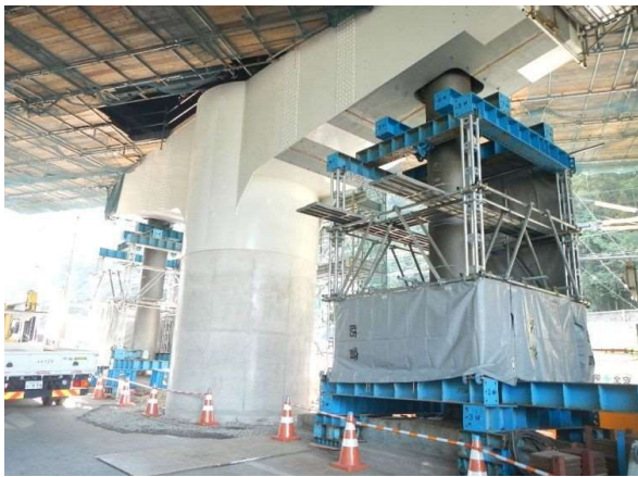
写真-12 既設ロッキング橋脚の撤去
