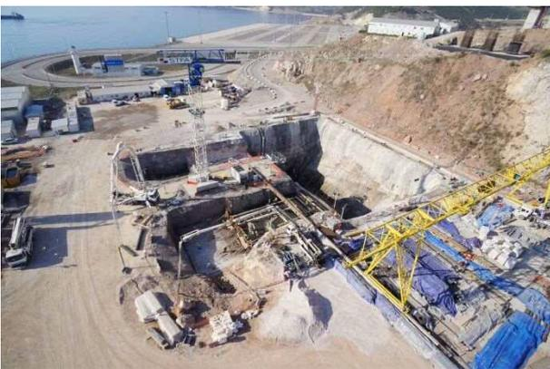
写真-6 北アンカレッジ掘削・コンクリート打設
