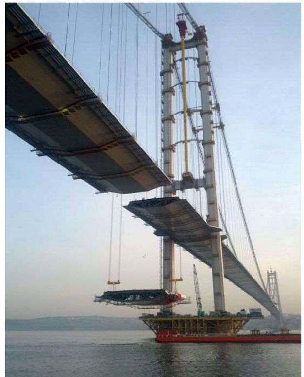
写真-21 閉合ブロックの架設(南側径間)
