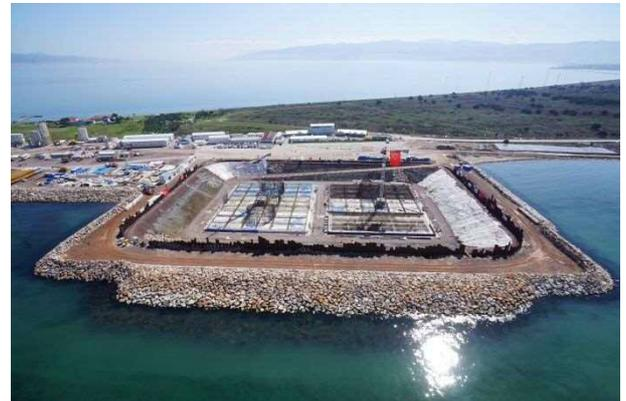
写真-2 ドライドックでのケーソン製作
