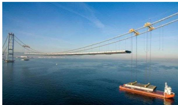
写真-15 LDによるメインスパンの補剛桁架設
