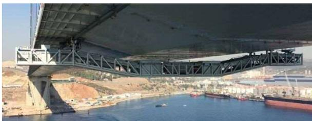
写真-17 桁下検査車
