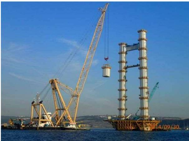
写真-9 FCによる主塔ブロック架設
