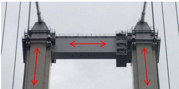
写真-16 主塔外面検査車(脚柱・水平梁)
