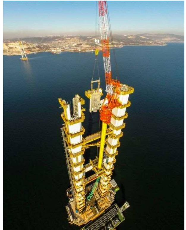
写真-10 JCCによる主塔パネル架設
