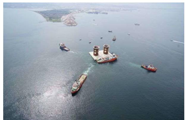
写真-4 ケーソン沈設
