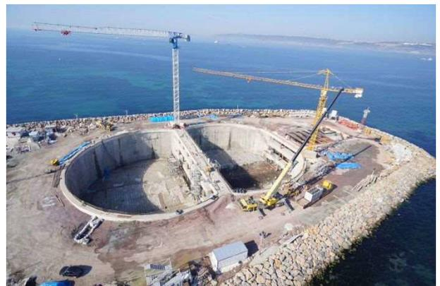
写真-7 南アンカレッジ コンクリート打設
