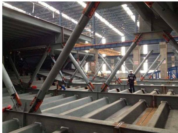
写真-13 補剛桁ブロック組立
