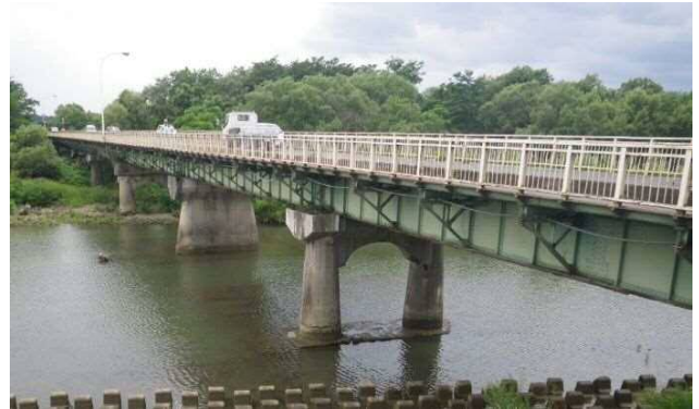
写真-1 九年橋 (大規模修繕工事前)
