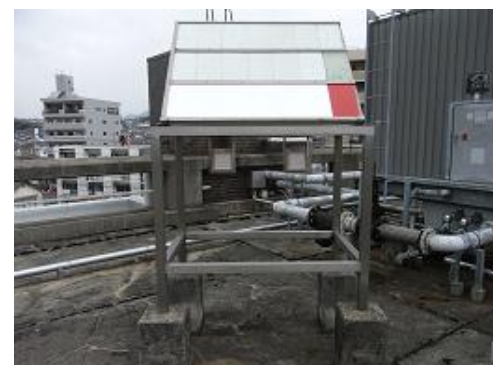
写真-3 中国技術事務所屋上暴露外観
