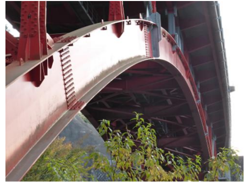
写真-1 塗装後28年経過したふっ素樹脂塗装
