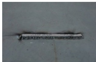
(3) 吊金具残し部
