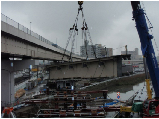
(1) 架設用吊金具使用状況
