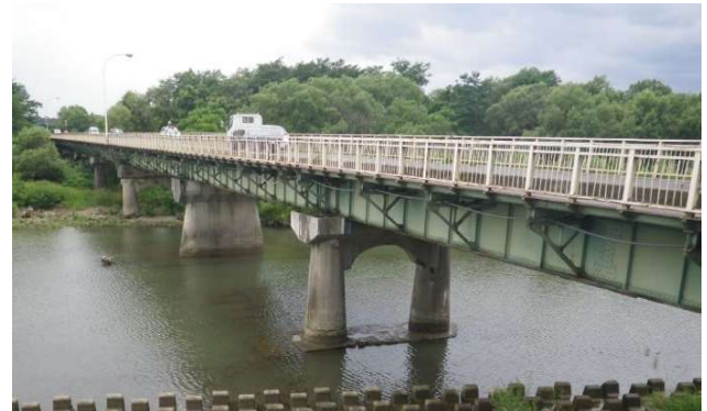
写真-1 九年橋 (大規模修繕工事前)
