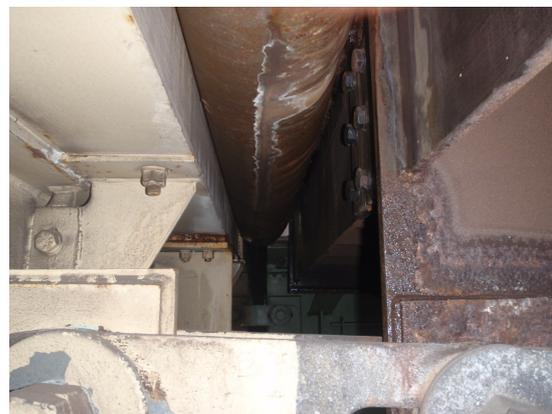
写真-4 伸縮装置からの漏水と桁端の腐食状況
