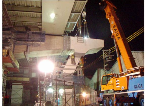
写真-8 鋼製橋脚横梁の架設状況
