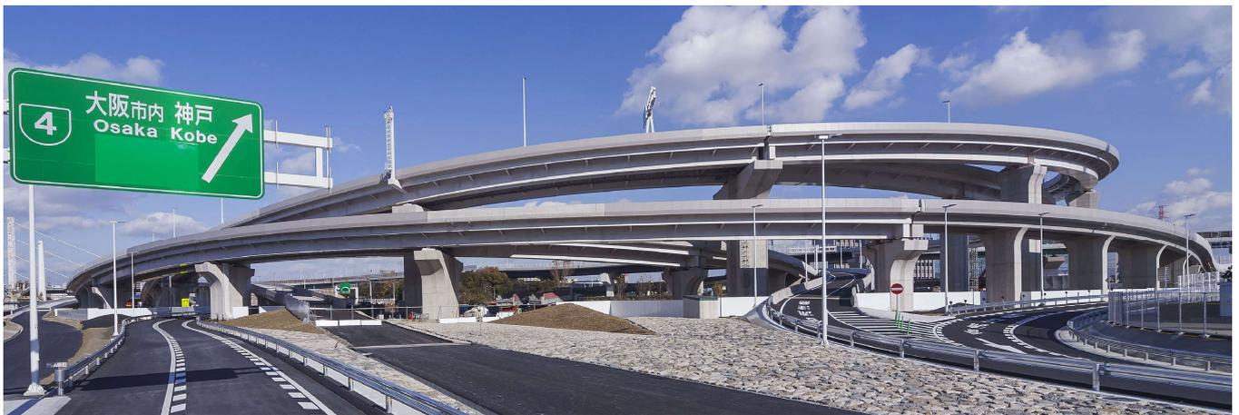
写真-15 三宝ジャンクション全景（鋼桁とコンクリート桁の連続性を考慮した景観設計）
