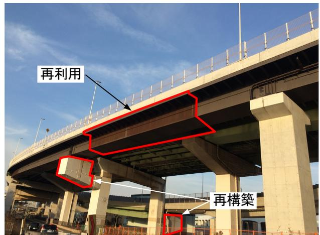
写真-3 【施工後】再利用されたランプ橋
