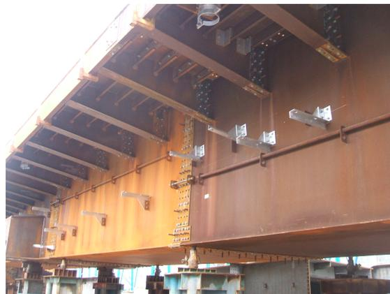
写真-7 仮組立状況 (右側が再利用桁)
