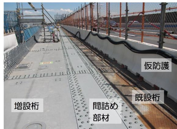
写真-11 鋼床版桁拡幅部
