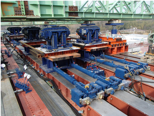
写真-3 エンドレス滑り装置
