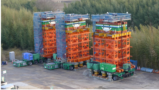
写真－5 一夜ベント設備
