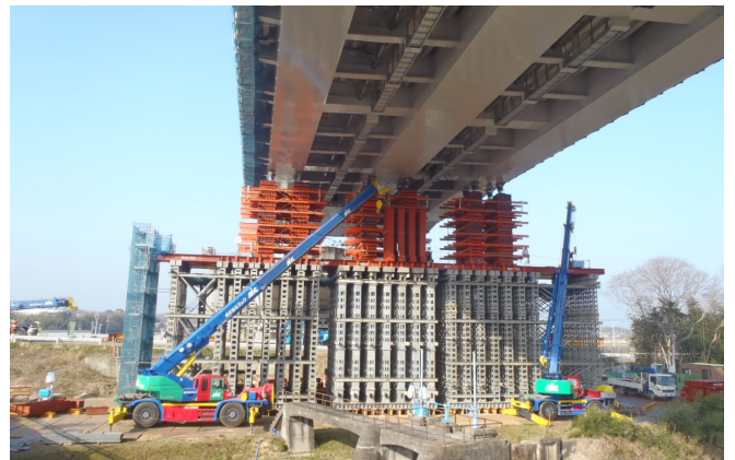
写真-13 BT2降下設備
