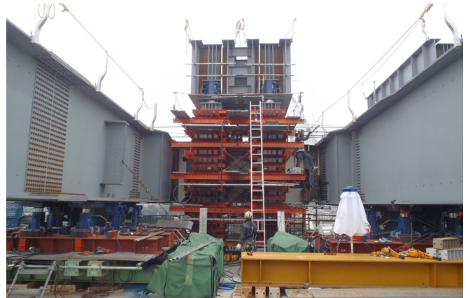
写真-12 BT1降下設備
