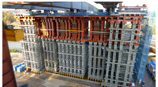
写真-2 BT2設備
