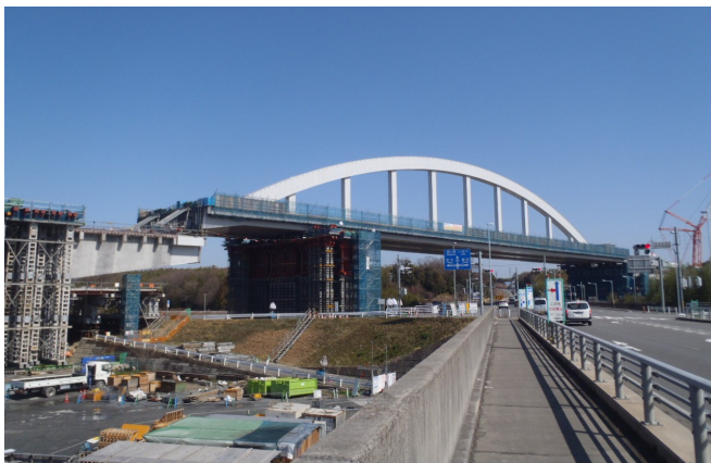
写真-11 送り出し完了
