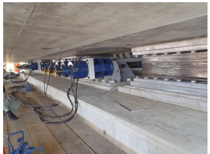
写真-15 セットバック作業状況
