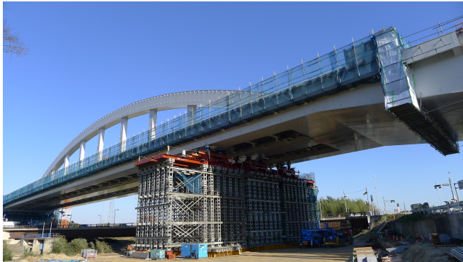
写真-14 降下完了
