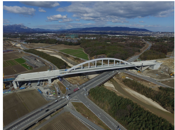
写真-1 施工完了
