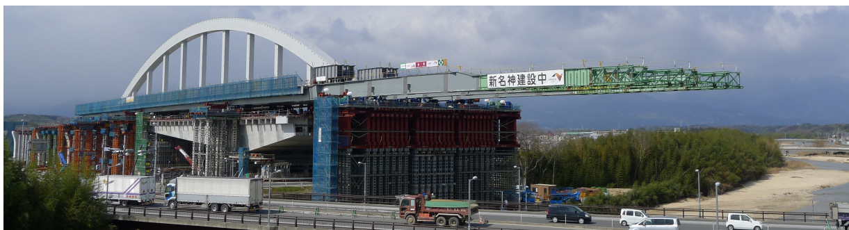
写真－9 送り出し架設全景（P2側）
