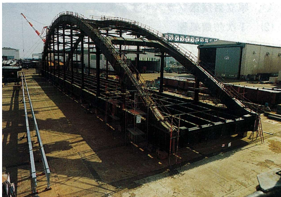
写真-23 全体立体の仮組立法
