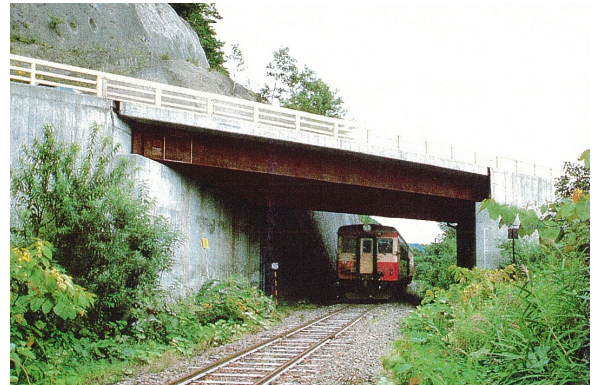
写真-33 尻別跨線橋
