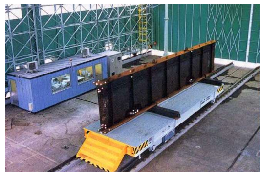
写真-25 トータルステーションによる自動計測 5)
