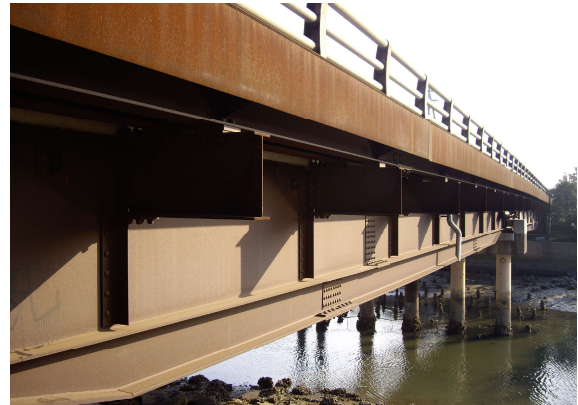
写真-32 知多2号橋
