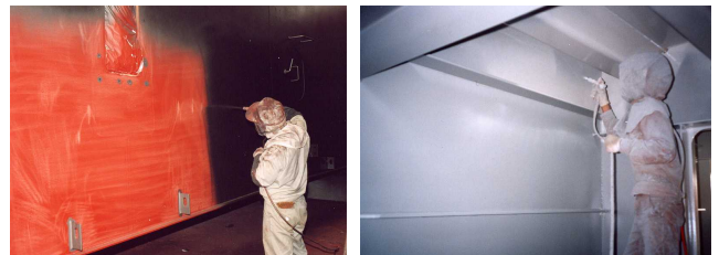
a) 施工状況(左側：外面、右側：内面)
