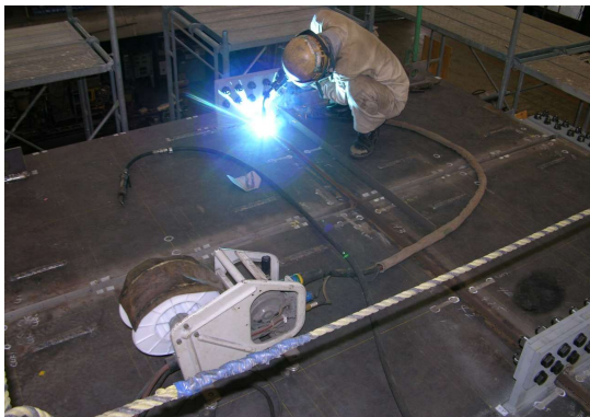
写真-20 半自動溶接
