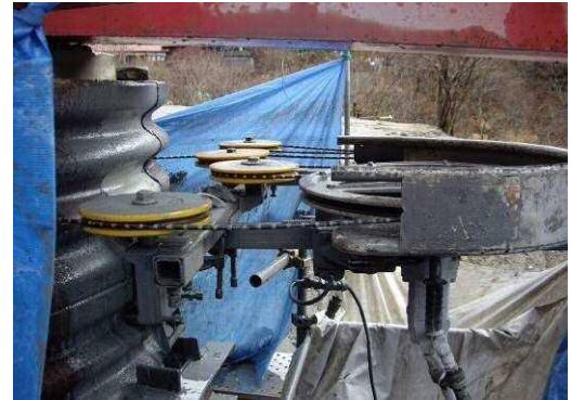
写真-36 ワイヤーソーによるベントの切断状況
