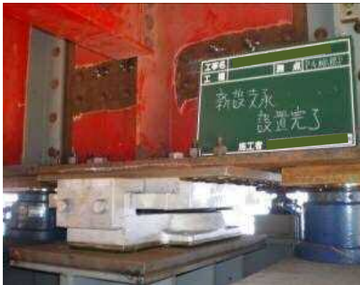
写真-11 中間橋脚部の支承取替完了状況
