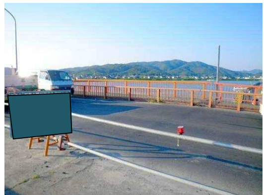
写真-61 仮設アスファルト舗装 (応急対応)
