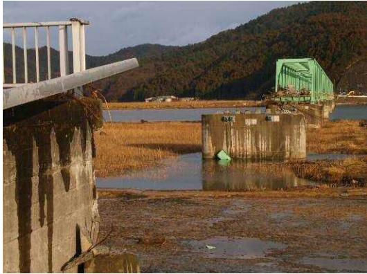
写真-4 東北地方太平洋沖地震の津波による被災状況
