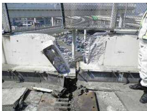
写真-18 壁高欄の損傷状況
