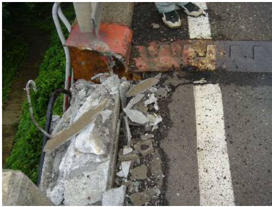
写真-6 伸縮装置周辺の地覆の損傷状況
