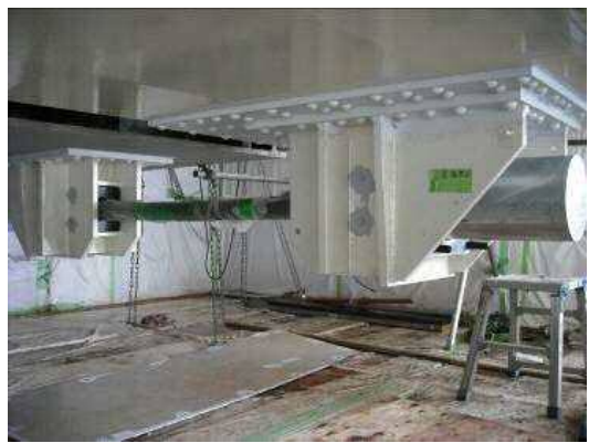
写真-30 新規設置した落橋防止装置
