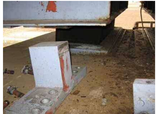
写真-55 サイドブロック損傷状況
