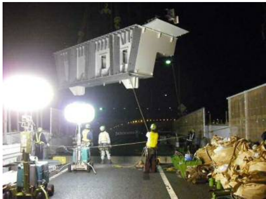
写真-28 新設桁の架設状況
