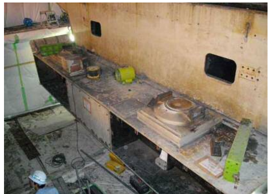
写真-27 損傷桁撤去後の受け桁(ゲルバー下側)
