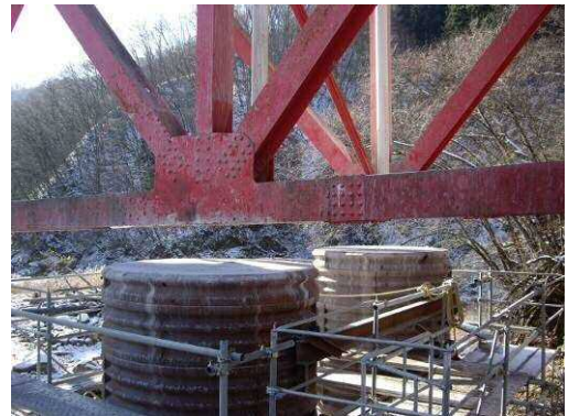
写真-37 切断後のベント
