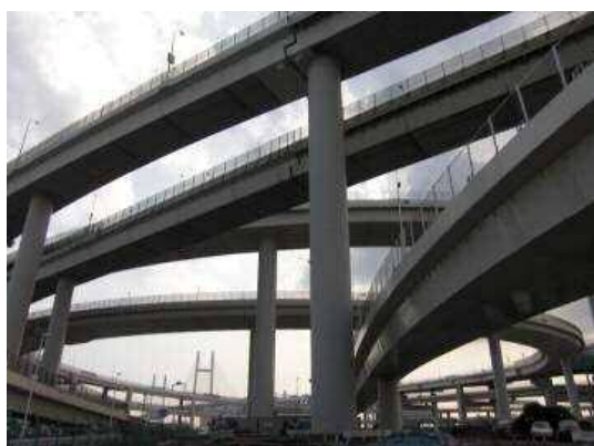
写真-15 ゲルバー部全景
