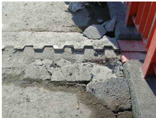
写真-59 伸縮装置損傷状況
