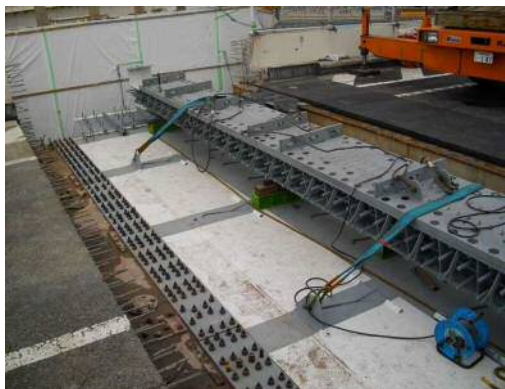
写真-29 伸縮装置の設置状況
