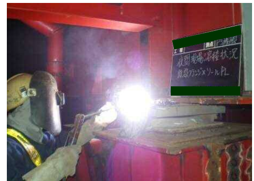
写真-14 現場溶接作業状況
