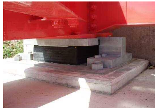
写真-41 支承取替後の状況
