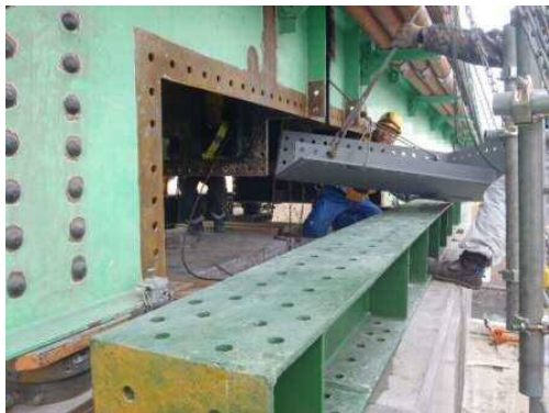
写真-53 部材取込状況
