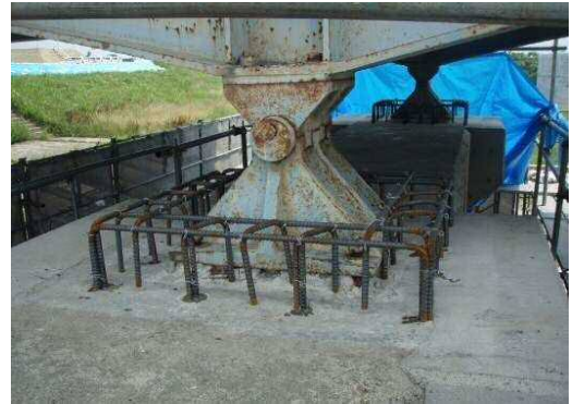
写真-65 差し筋配筋状況
