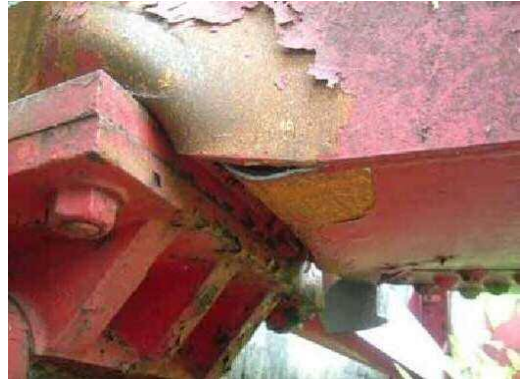
写真-33 下弦材支点近傍の損傷状況
