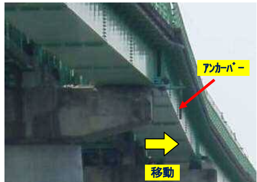
写真-43 主桁横移動の状況
