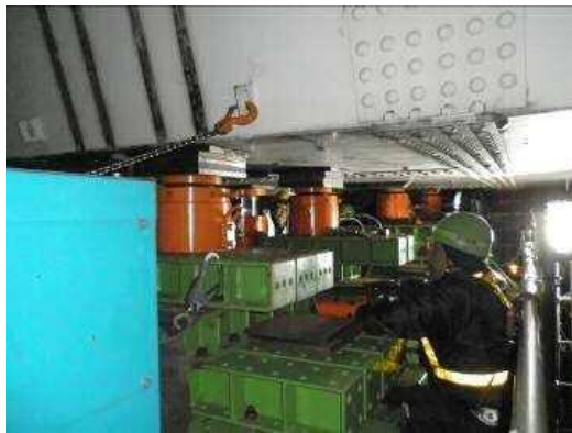
写真-21 ジャッキアップ状況
