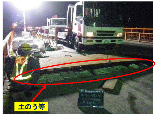
写真-60 高さ調整状況 (応急対応)
