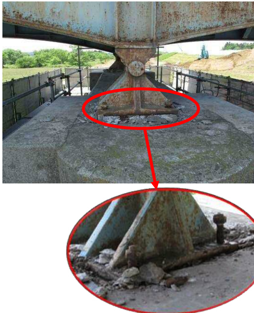
写真-64 支承アンカーボルトの抜け出し
