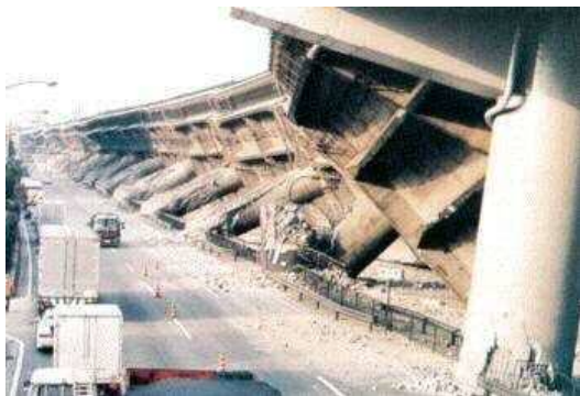
写真-1 兵庫県南部地震の被災状況(土木学会)
