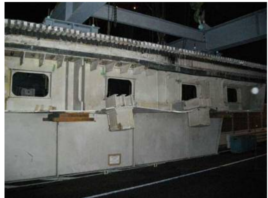
写真-26 撤去した損傷桁(ゲルバー上側)
