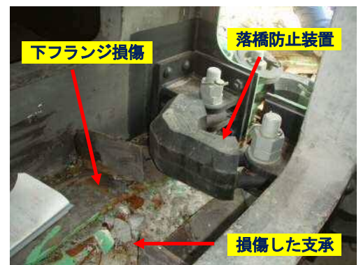
写真-45 箱桁下フランジの損傷状況
