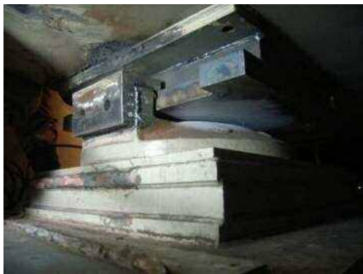
写真-22 仮上沓設置状況
