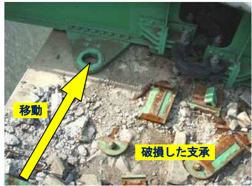
写真-42 橋脚上の損傷状況
