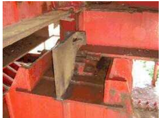
写真-9 橋軸直角方向のストッパー
