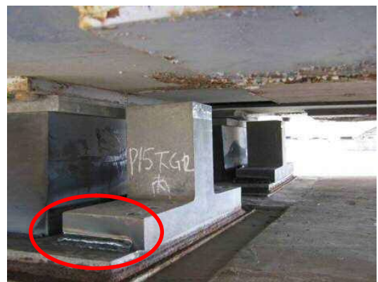
写真-56 現場溶接による応急対応
