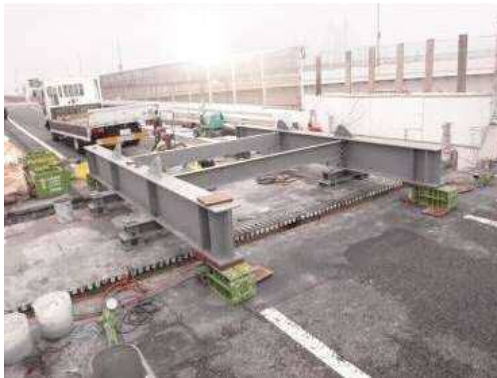
写真-24 仮支持梁
