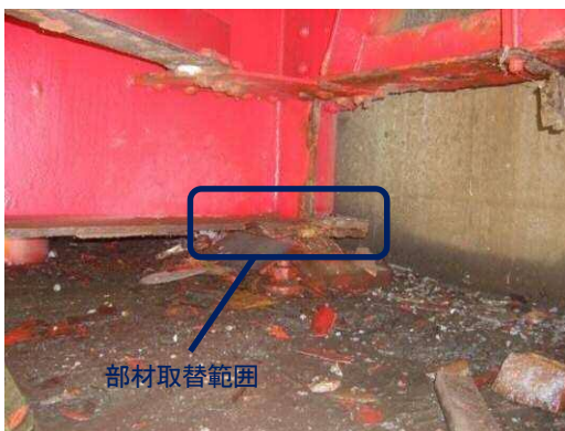
写真-12 橋台部の支承の破損状況および主桁下フランジの腐食状況
