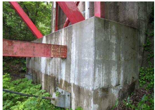
写真-34 支点部 RC 巻立による応急対応
