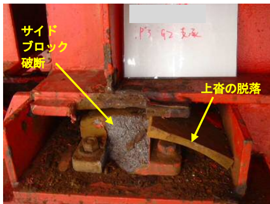
写真-7 BP-A 支承のサイドブロック損傷 および上沓の脱落状況
