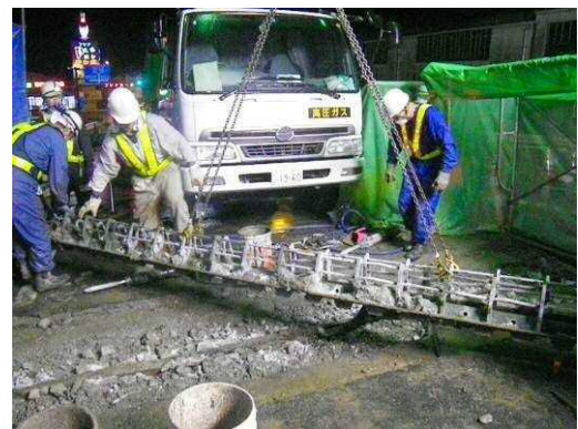
写真-62 既設伸縮装置撤去状況 (本復旧)
