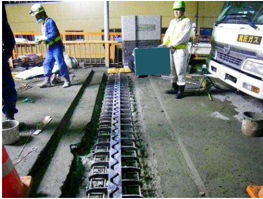
写真-63 新設伸縮装置設置状況（本復旧）
