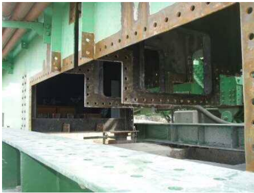
写真-52 主桁切断状況
