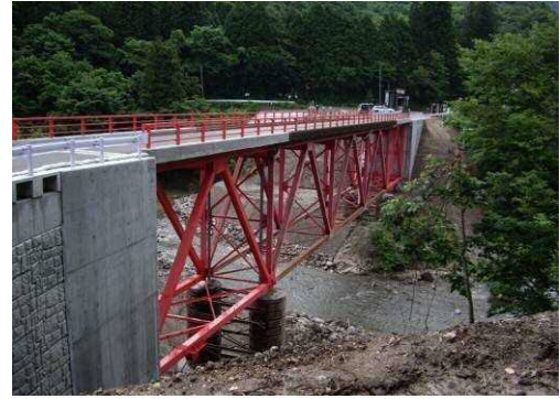
写真-40 トラス部材の架設完了状況
