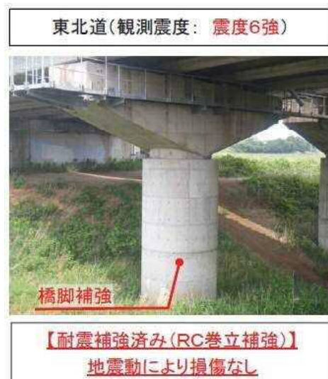
写真-3 耐震補強の有無による損傷状況の差 (東北地方太平洋沖地震) 1)
