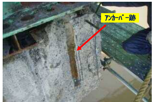
写真-44 アンカーバーで破壊された橋脚先端部
