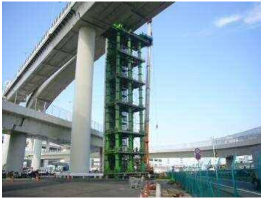
写真-20 ベント設置状況
