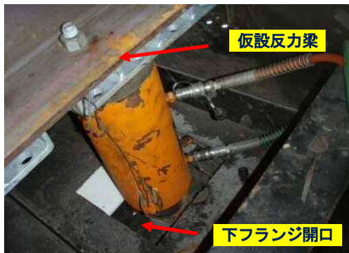
写真-46 ジャッキアップ設備
