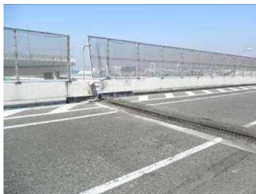
写真-17 伸縮装置の損傷および路面の段差状況
