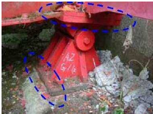
写真-32 支承の損傷状況
