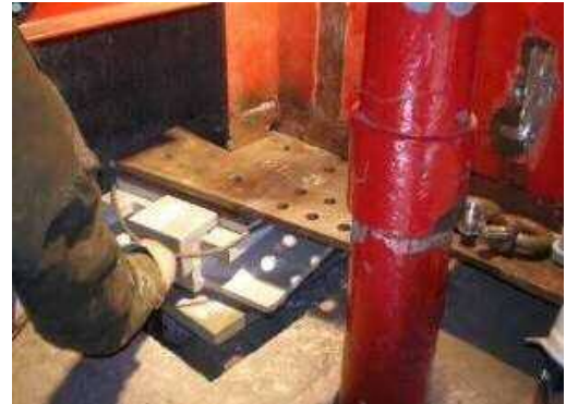
写真-13 主桁下フランジの併用継手
