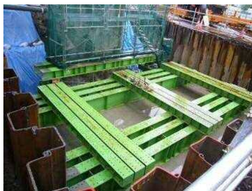
写真-19 ベント基礎施工状況
