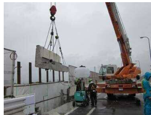
写真-23 壁高欄ブロック撤去状況
