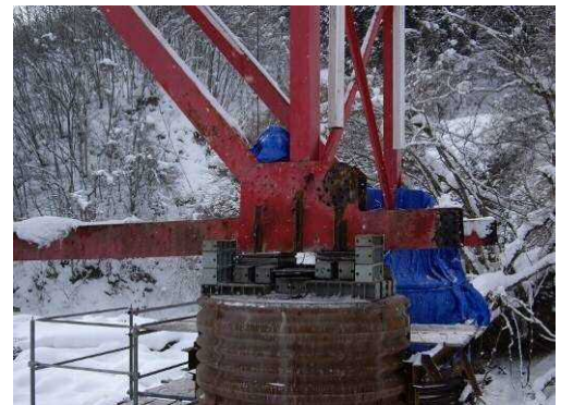
写真-38 仮支点部
