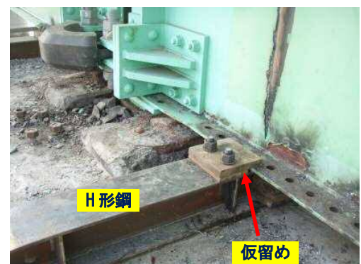
写真-49 横移動後の仮支持状況
