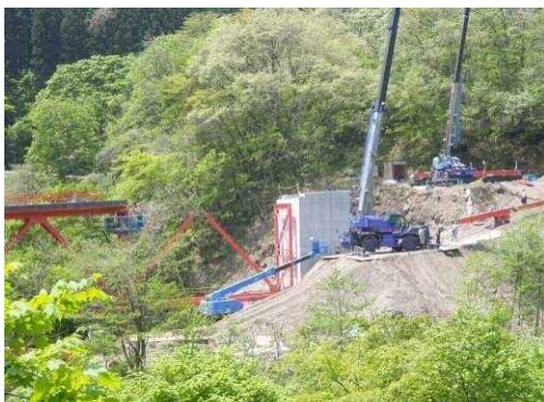
写真-39 トラス部材の架設状況
