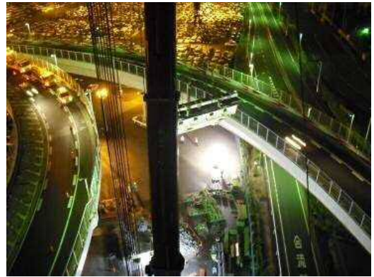
写真-25 損傷桁の撤去状況
