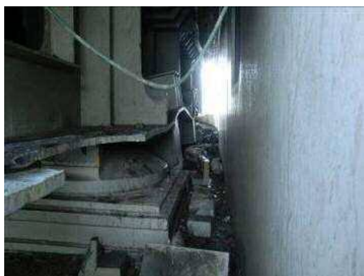
写真-16 支承および主桁の損傷状況
