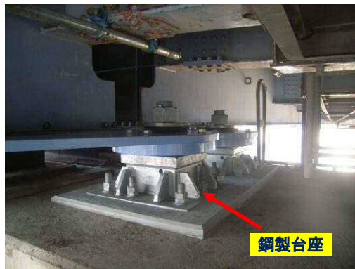
写真-58 アンカーバーによる本復旧(2)
