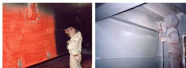
a) 施工状況（左側：外面、右側：内面）
