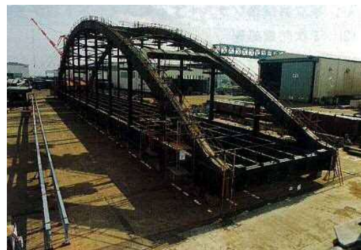
写真-23 全体立体の仮組立法
