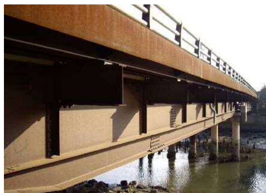
写真-32 知多2号橋
