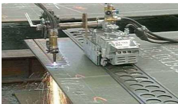
写真-5 ポータブルガス切断
