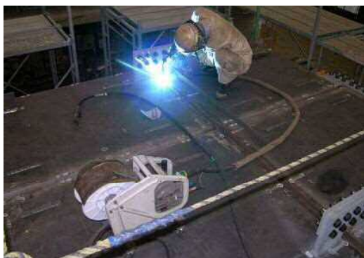
写真-20 半自動溶接
