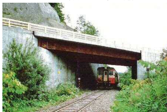
写真-33 尻別跨線橋
