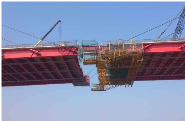
写真-1 2 閉合作業(桁の架設)
