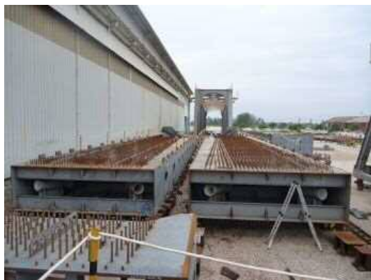
写真－3 水平全体仮組立
