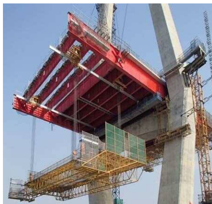
写真-6 移動防護工設備の設置
