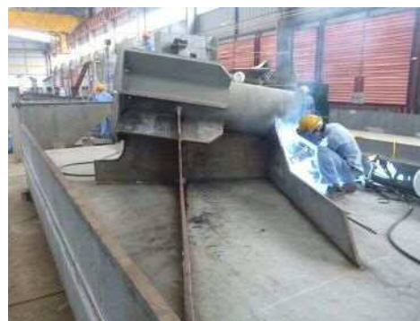
写真－２ ケーブル定着部溶接状況
