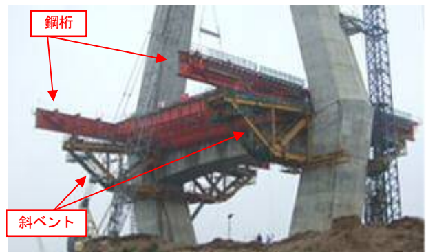
写真-4 鋼桁の架設
