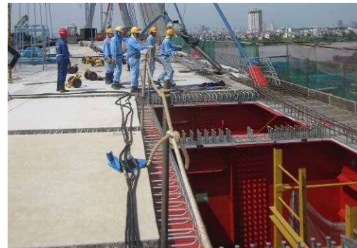
写真-7 ケーブル架設(桁側)
