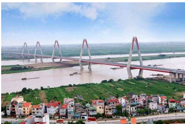
写真-1 Nhat Tan 橋 Main Bridge 全景
