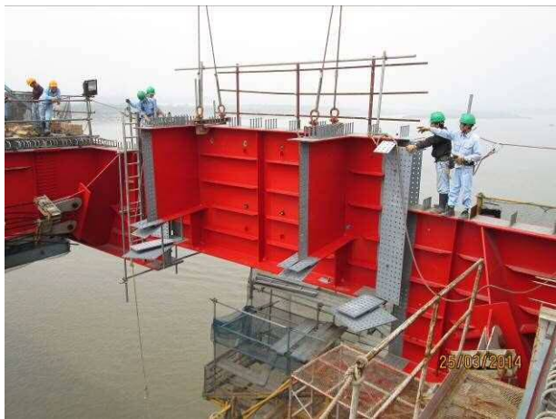
写真-1 3 閉合作業(桁の落とし込み)
