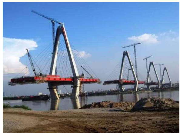
写真-8 バランシング張出架設
