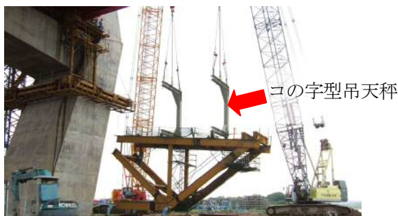
写真-5 斜ベントの撤去
