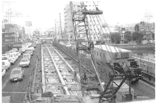
写真-7 C橋 床版取替え工事<sup>5)</sup>
