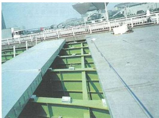
写真-2 A橋 床取替え工事<sup>3)</sup>
