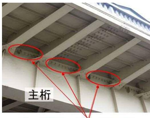
取り替え鋼床版に主桁(縦桁)を設け、既設の主桁(縦桁)と全長に渡って接合
