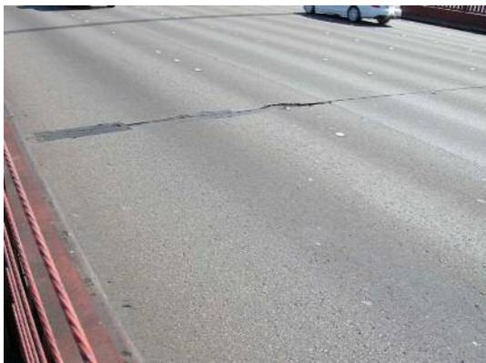
写真-23 舗装の劣化
