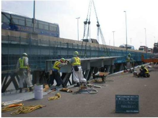
写真-21 I 橋床版拡幅工事
