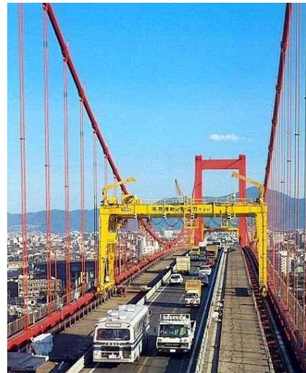
写真-20 H橋床版取替え工事
