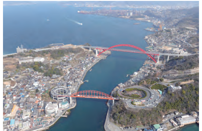
写真-1 音戸大橋（手前）と第二音戸大橋（奥）
