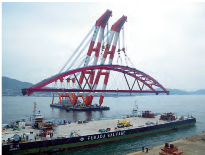
写真-2 吊上げ状態と台船の進入
