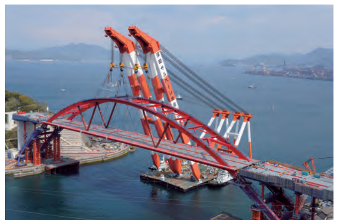
写真-6 大ブロック架設状況
