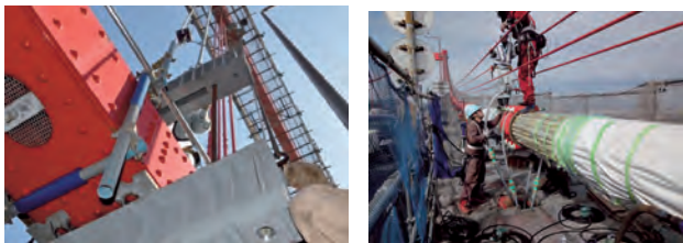
写真-34 仮吊り設備 写真-35 ハンガーロープ取替え
