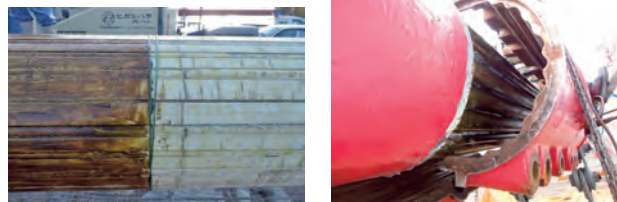
写真-30 防錆ペースト塗布(左) 写真-31 ケーブルバンド復旧
