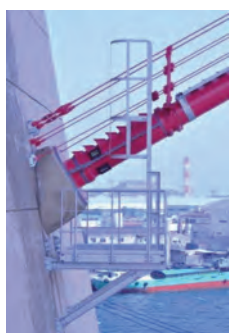
写真-12 新設管理路
