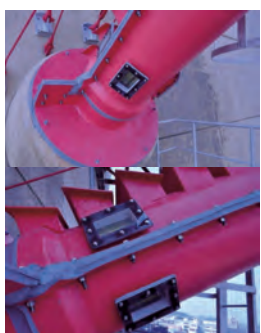
写真-13 新設ケーブルカバー
