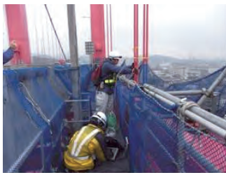
写真-43 振動法による張力測定
