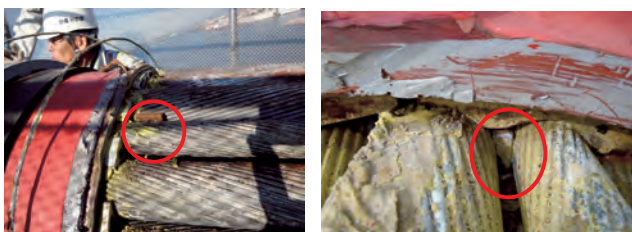
写真-26 ストランド間の鉄片 写真-27 ケーブルバンド内の鉄片
