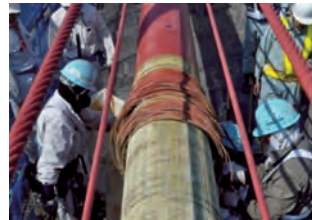
写真-4 ラッピングワイヤー撤去
