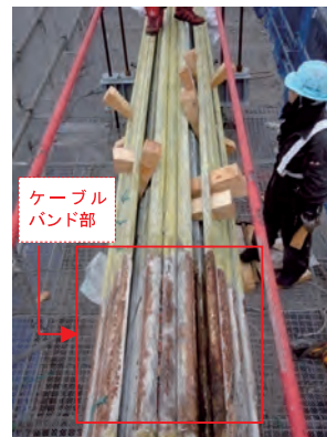
写真-6 くさび打ち込み
