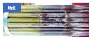
写真-9 橋台部(地側)の外観
