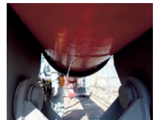
写真-3 主ケーブルからの漏水
