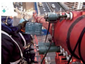
写真-47 バンドボルト取替え
