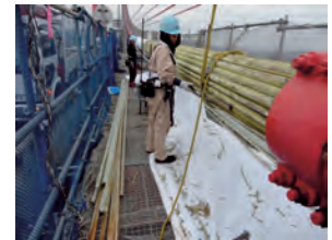
写真-5 アルミフィラー除去
