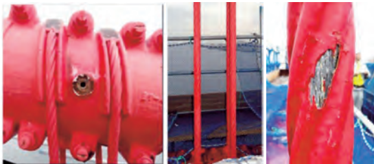
写真-36 ハンガーロープの外観
