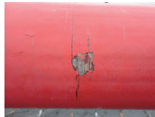
写真-2 主ケーブル外観
