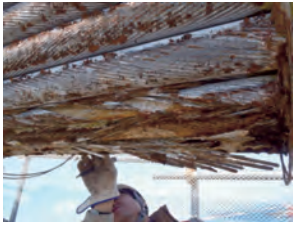
写真-17 素線破断 (格点 41)
