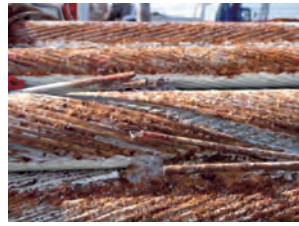
写真-18 素線破断 (格点 63)
