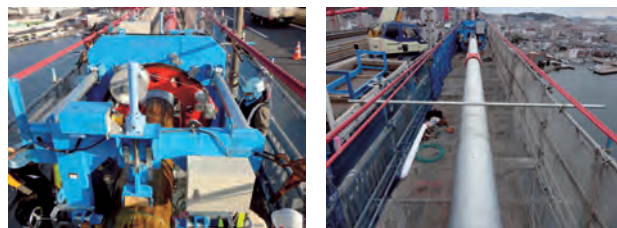
写真-28 ラッピングマシン 写真-29 ワイヤーラッピング後
