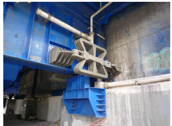
写真-1 旧橋に取付けられたダンパー
