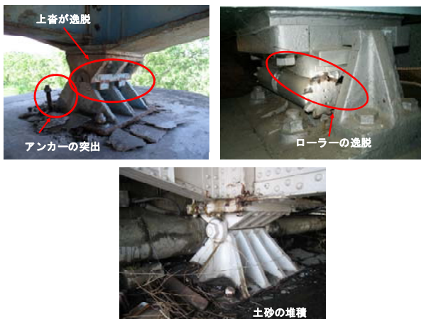
写真-3 ピン支承の主な損傷事例
