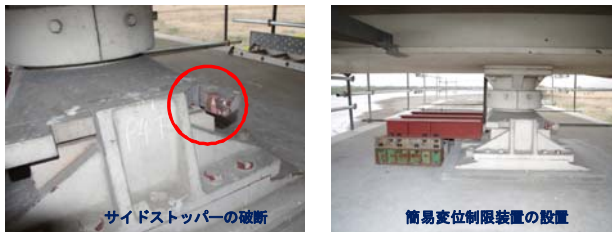
写真-12 サイドストッパーの破断と応急対策
