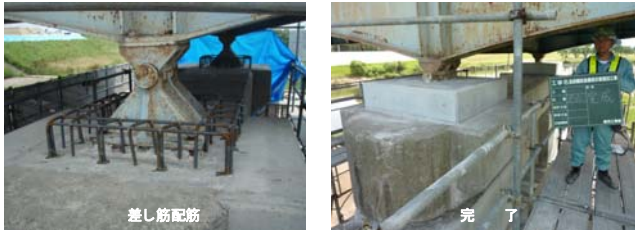
写真-11 下沓コンクリート巻立て
