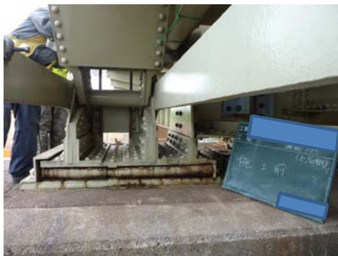
写真-19 ローラー部の腐食・摩耗
