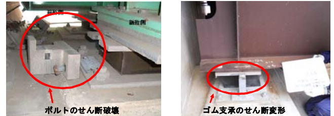
写真-5 ゴム支承の損傷事例
