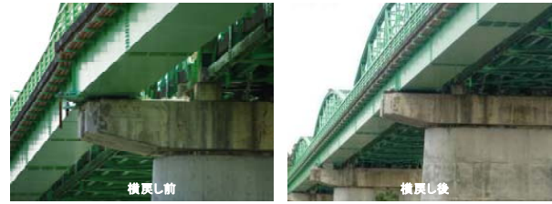
写真-8 桁の横戻し
