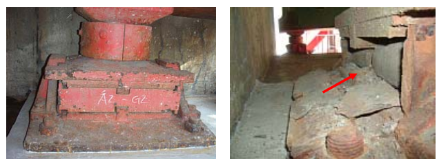
写真-17 発錆・腐食状況
