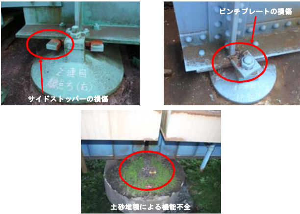
写真-1 線支承の主な損傷例
