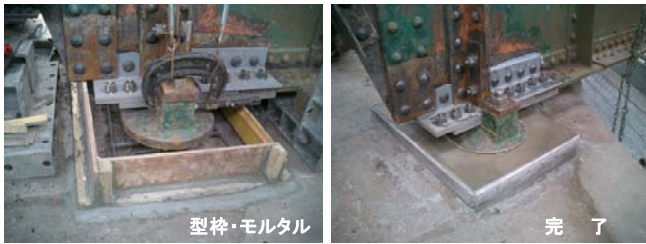
写真-24 既設支承設置・モルタル打設
