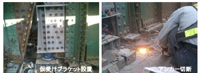
写真-22 桁仮受け・支承撤去
