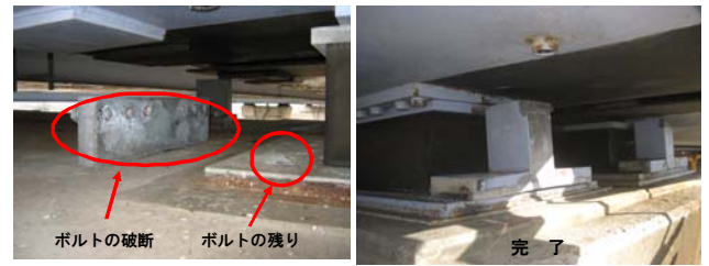
写真-14 サイドストッパーの破断と応急対策
