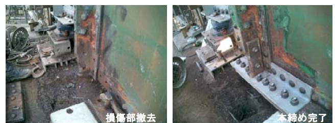
写真-23 亀裂損傷部撤去・新規部材設置
