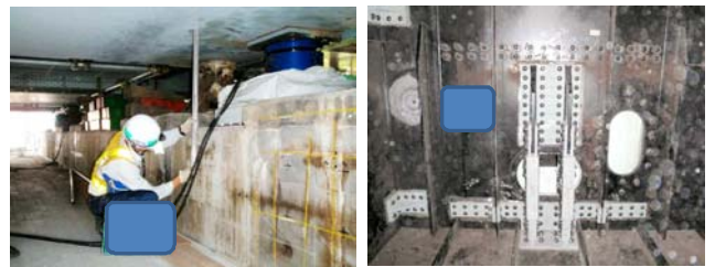
写真-25 箱桁の仮受け
