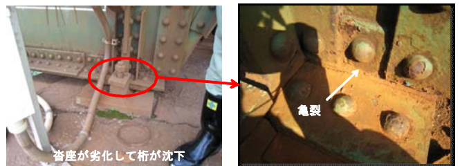
写真-21 支点沈下による桁損傷
