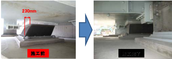
写真-16 ゴム沓残留変形開放
