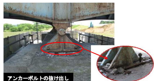
写真-10 アンカーボルトの抜け出し
