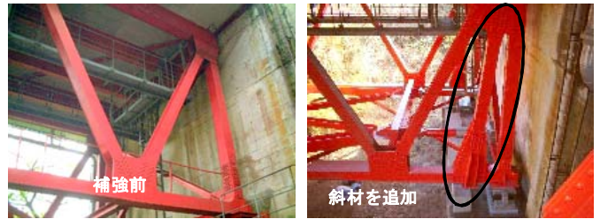
写真-30 追加斜材による仮受け
