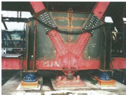
写真-29 ガセットによる仮受け
