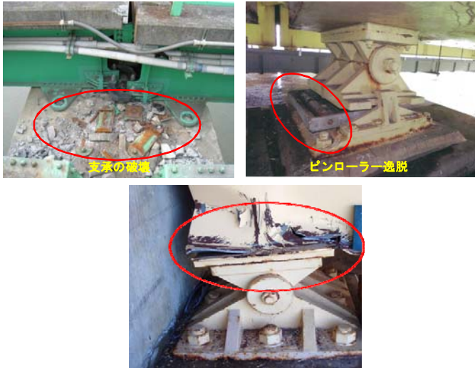
写真-6 支承部機能喪失
