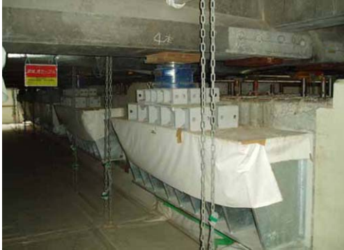
写真-27 下部工付きブラケットを設置して仮受け
