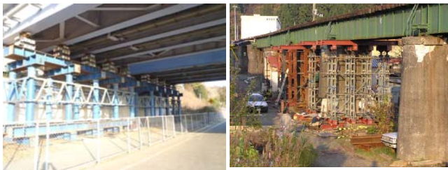
写真-28 ベントによる仮受け
