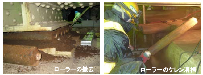
写真-20 ローラー撤去・清掃
