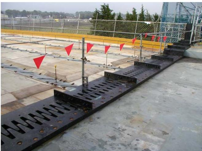
写真-7 鋼床版用伸縮装置
