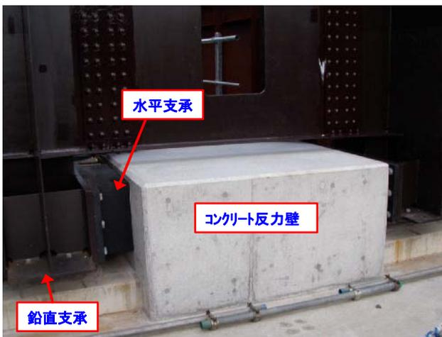
写真-3 コンクリート反力壁タイプ設置例
