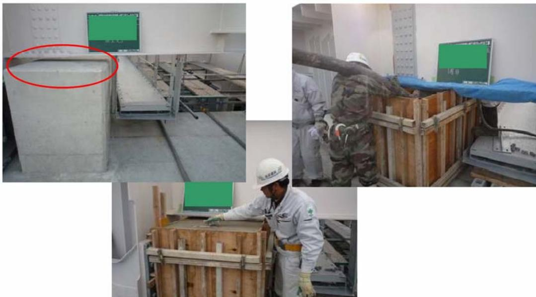
写真-6 縦置き型コンクリート反力壁タイプの施工例（3）
