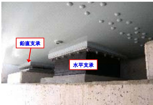
写真-1 平置き型設置例
