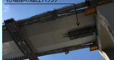
桁端部の油圧バッファー
