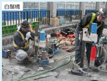
吊り孔用のコア削孔
