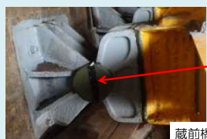
支承軸部の防錆対策
