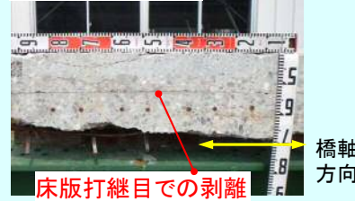
試験体No.5-2(2主鈹桁)
