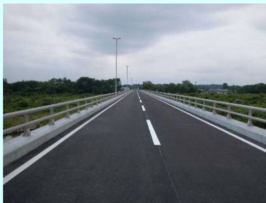
写真 九年橋 (大規模修繕工事後、2015年6月撮影)
