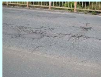
写真 舗装のひび割れ
