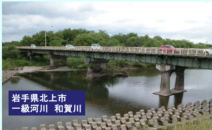
写真 九年橋(大規模修繕工事前、2012年6月撮影)
