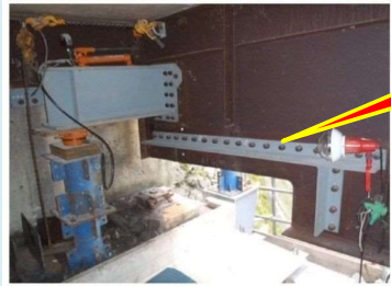
損傷部切断時の補強部材を設置
