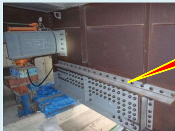
主桁部材取り替え後に補強材撤去
