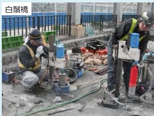
吊り孔用のコア削孔
