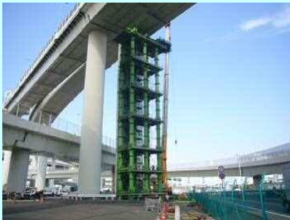
ベント設置状況
