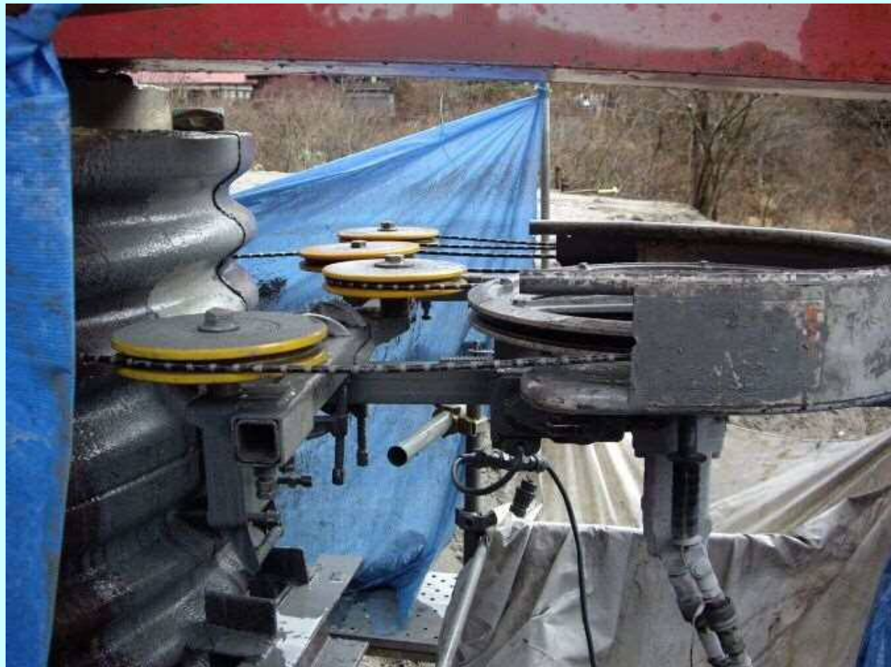
ミニワイヤーソーによる切断
