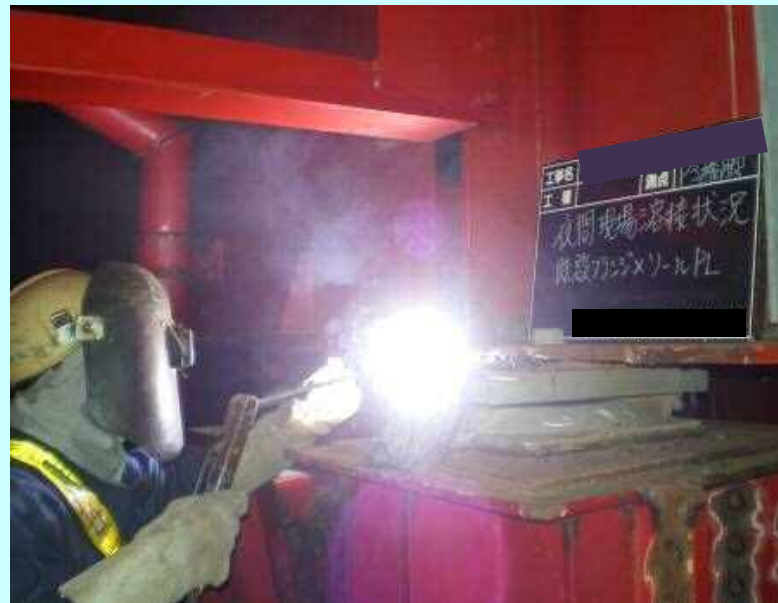
現場溶接の状況（夜間交通規制）
