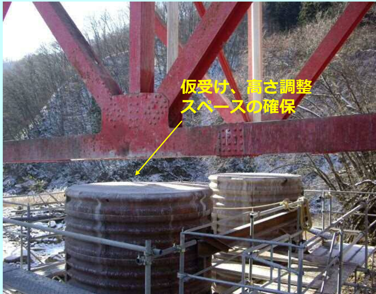
部分撤去後の状況
