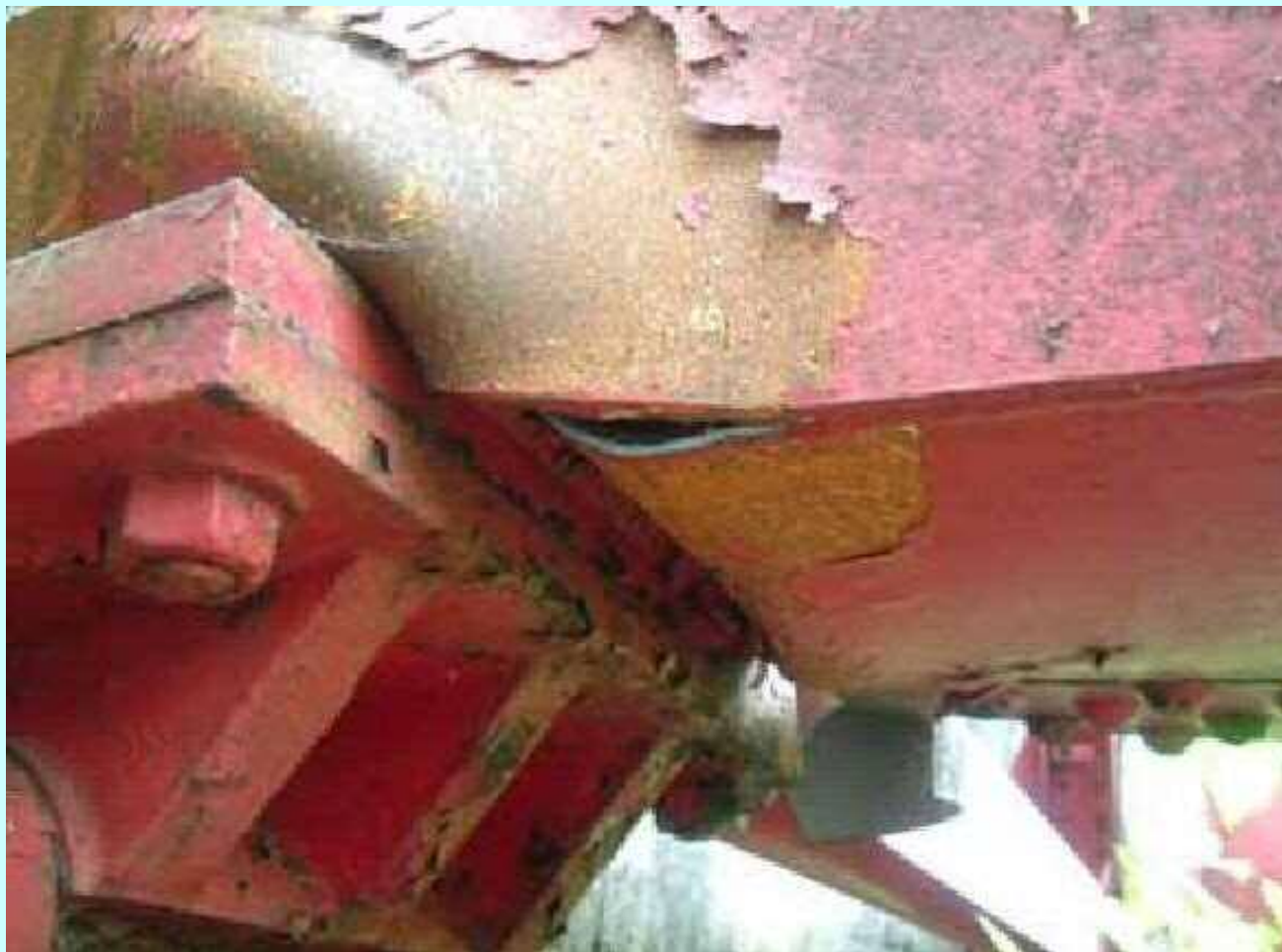
下弦材の損傷状況
