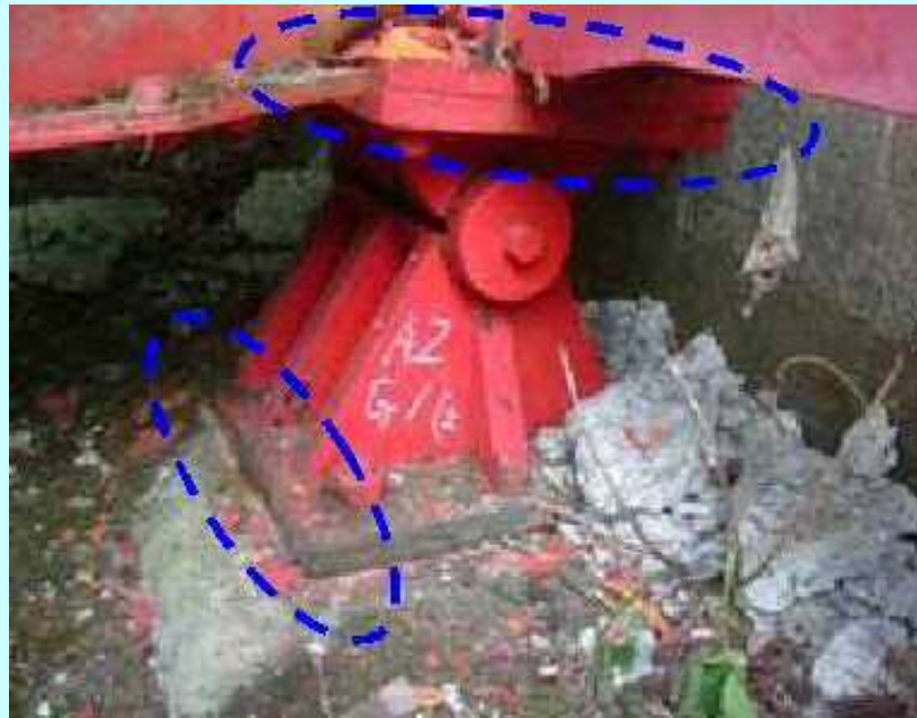
支承の損傷状況
