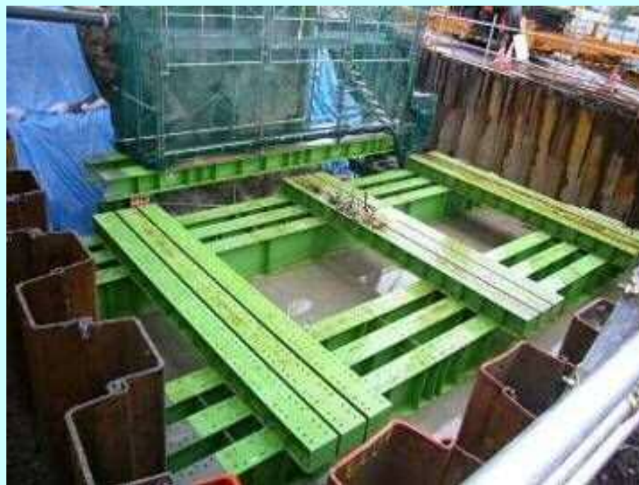
ベント基礎の設置状況
