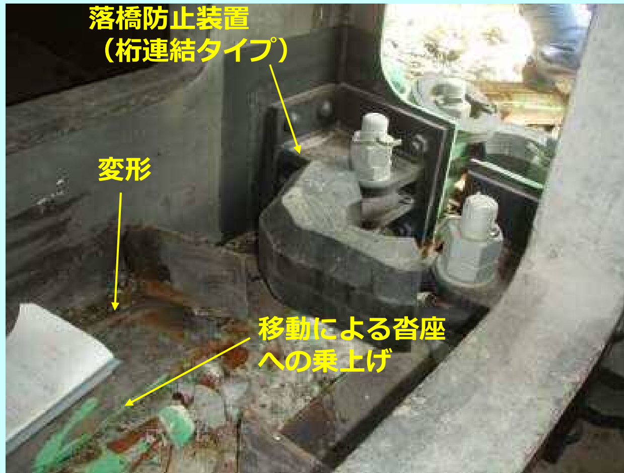
下フランジの変形損傷 (箱内端部)
