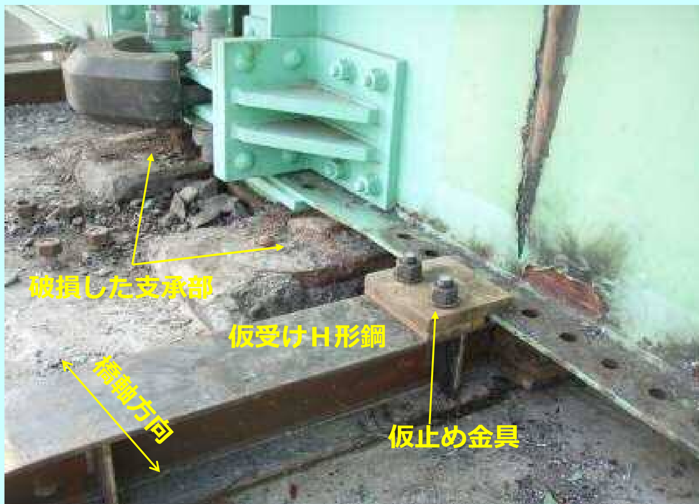
横移動後の仮受け状況
