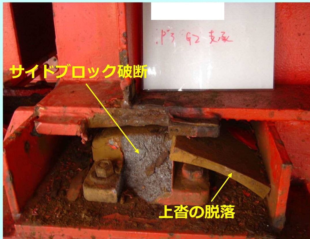
BP・A支承の破損状況（P3橋脚部）
