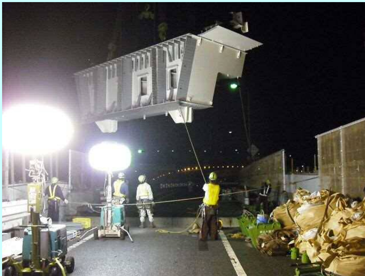
新設桁架設の状況
