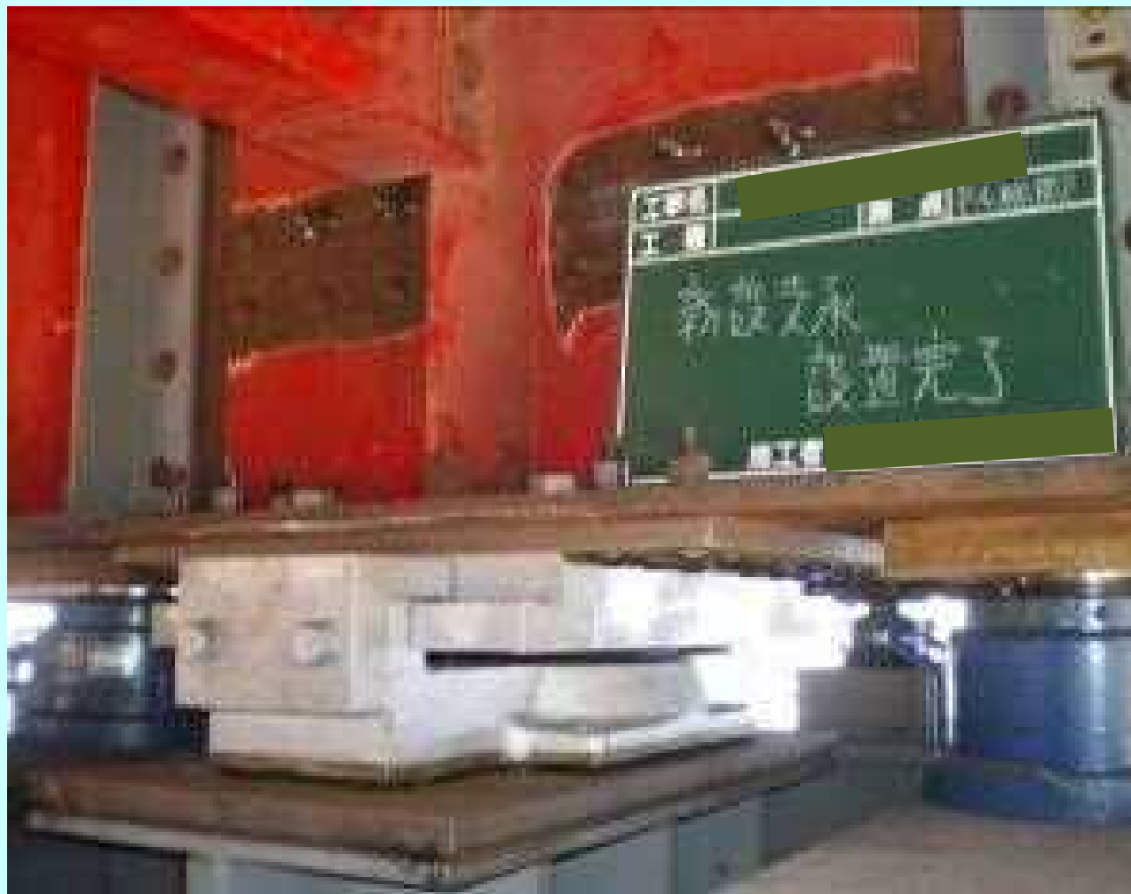
支承取替え完了 (P4橋脚部)
