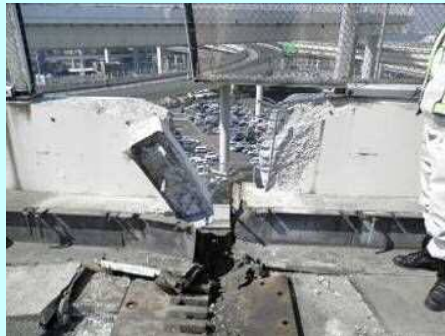
壁高欄の損傷
