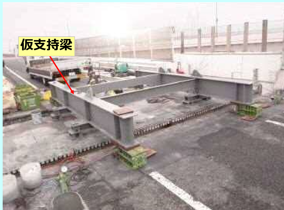
仮支持梁の設置状況
