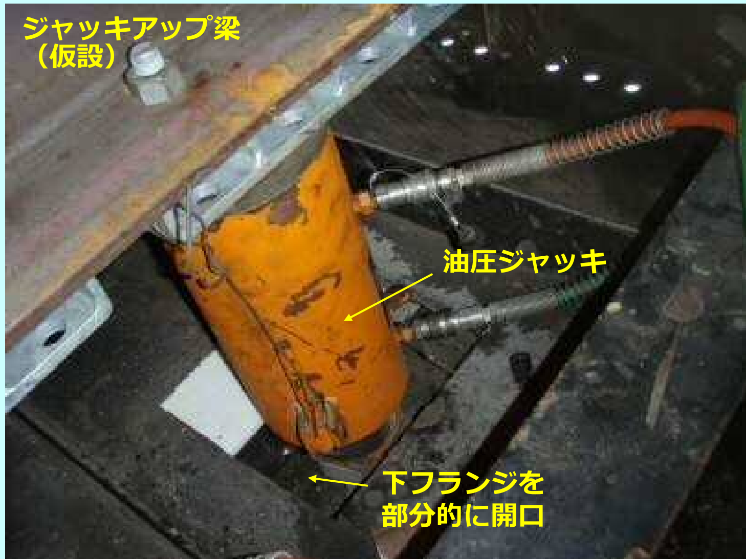
ジャッキアップの状況
