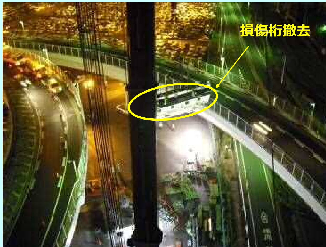
損傷桁撤去の状況
