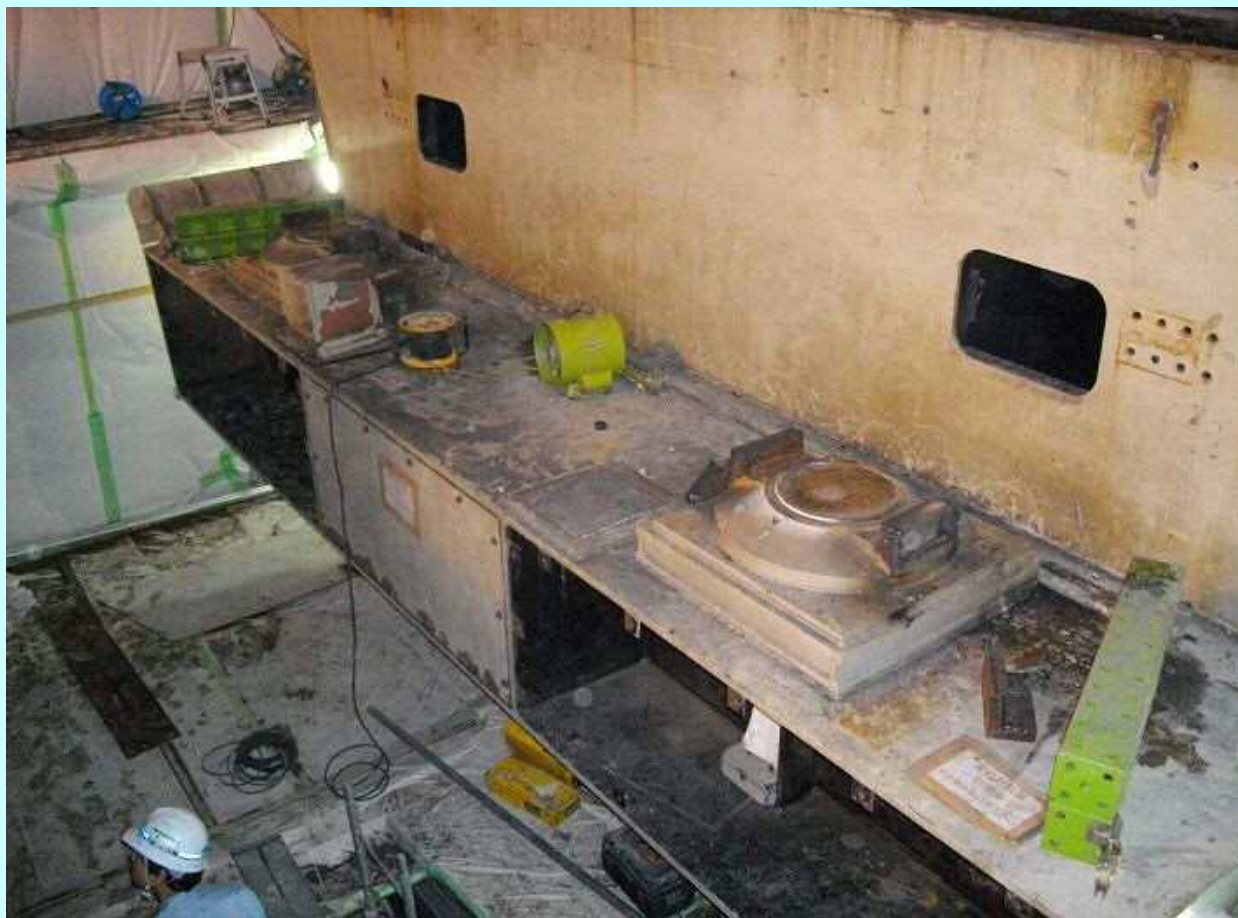
損傷桁撤去後の既設橋の状況
