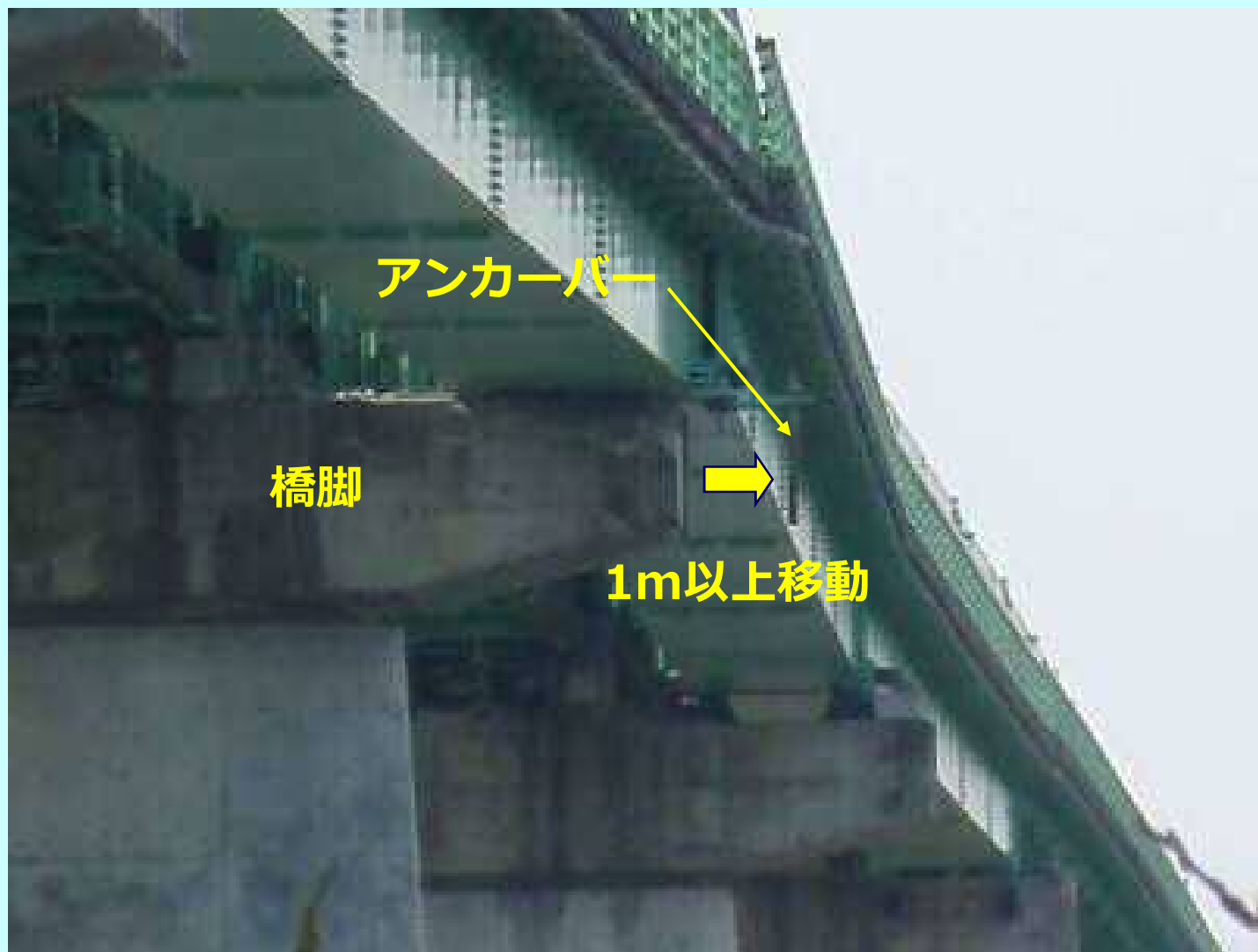
主桁横移動の状況
