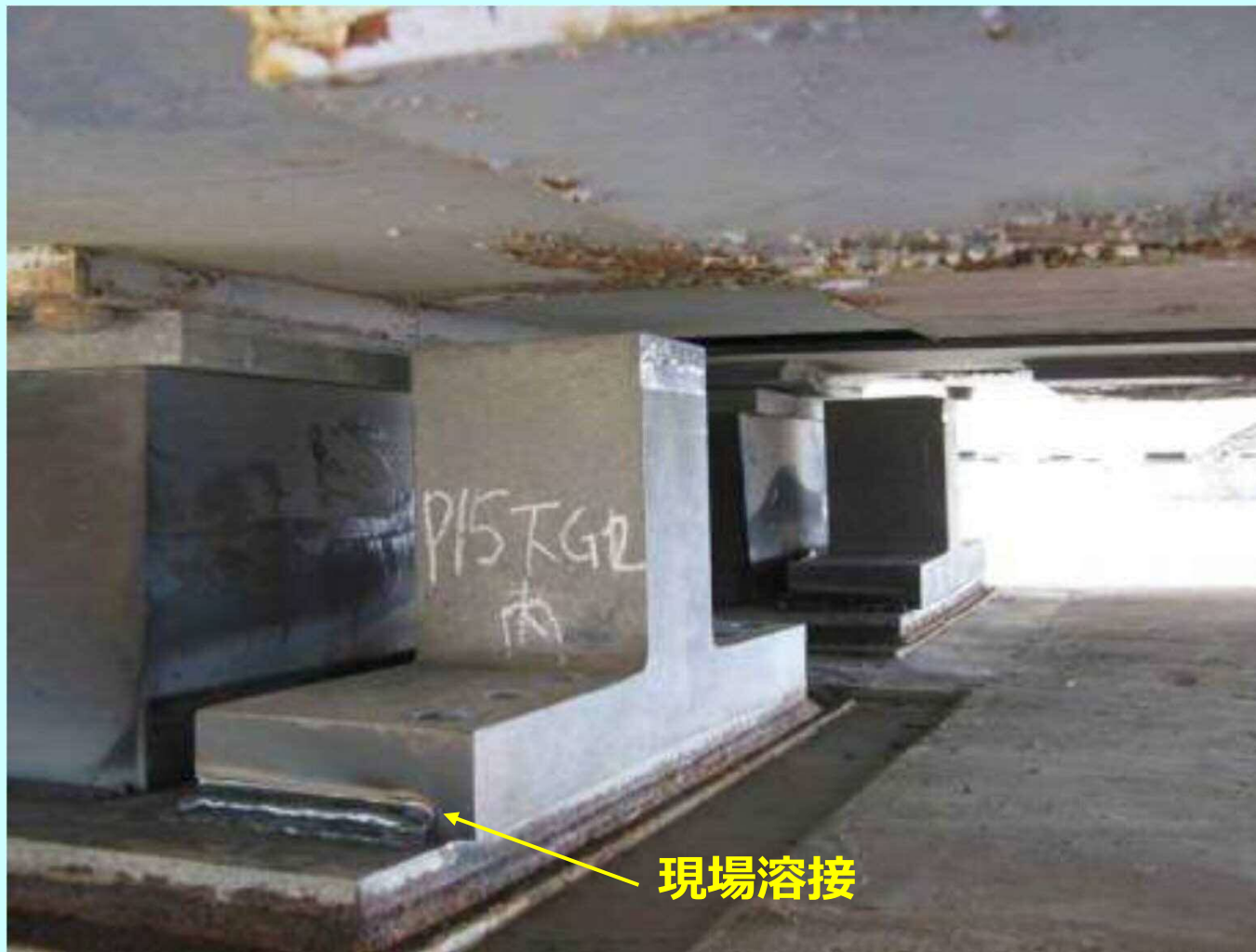
現場溶接による仮設置
