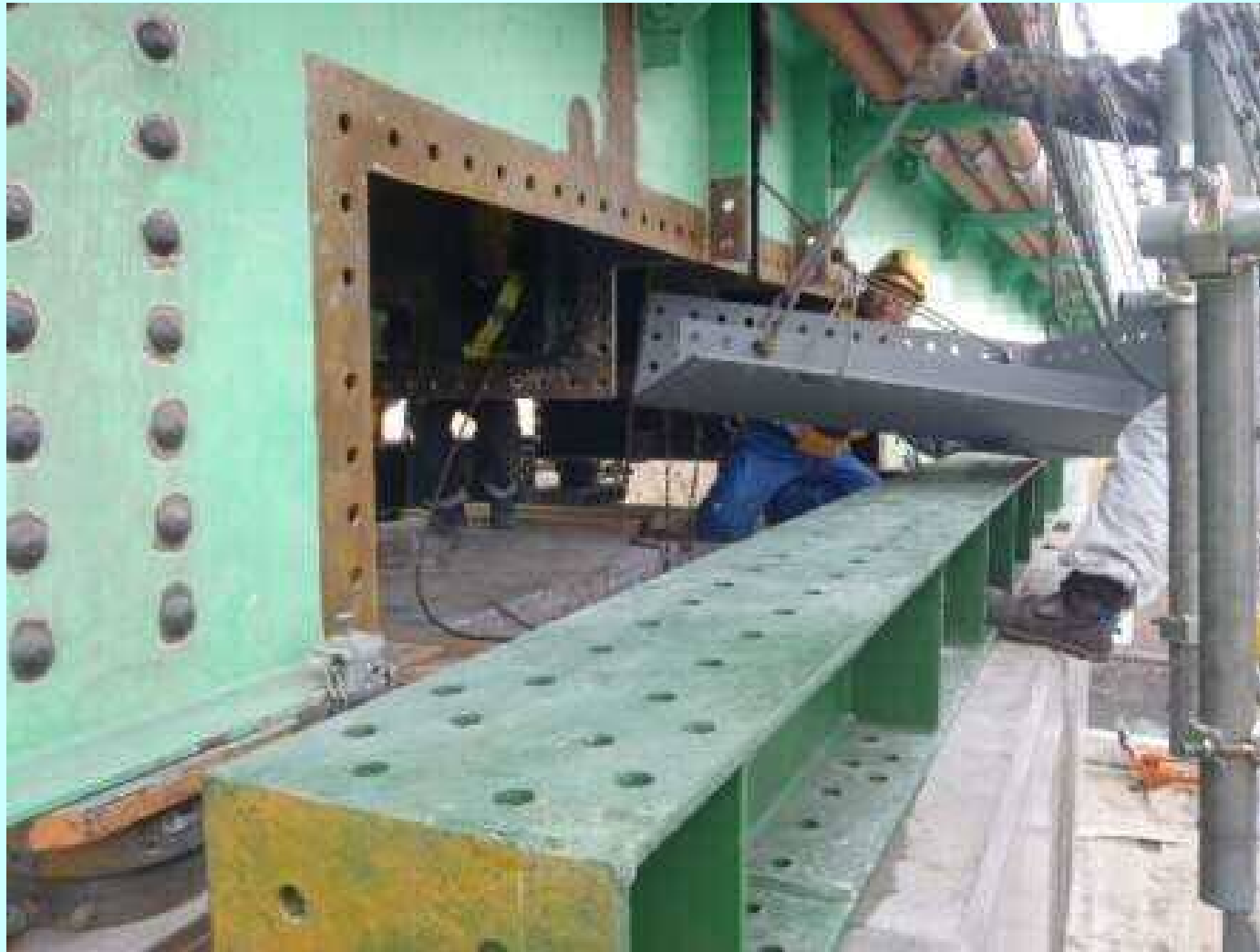
新設部材の取込み状況
