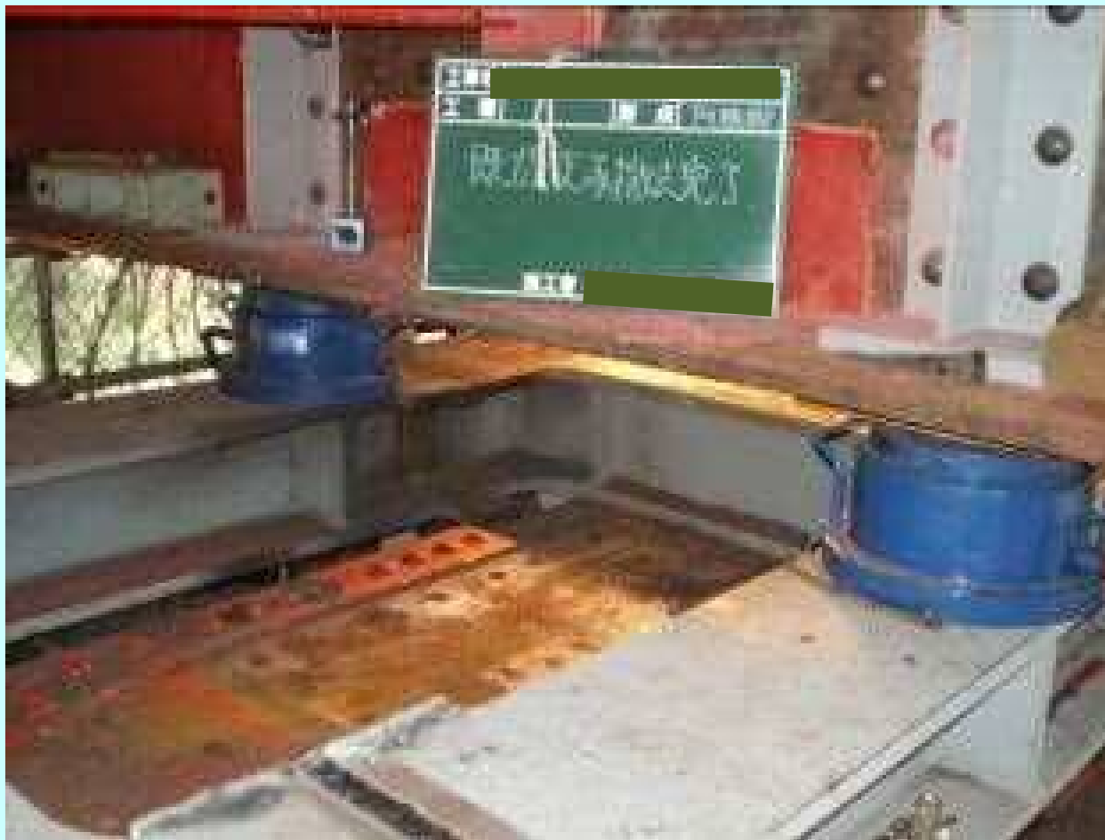
ジャッキアップの状況 (P4橋脚部)
