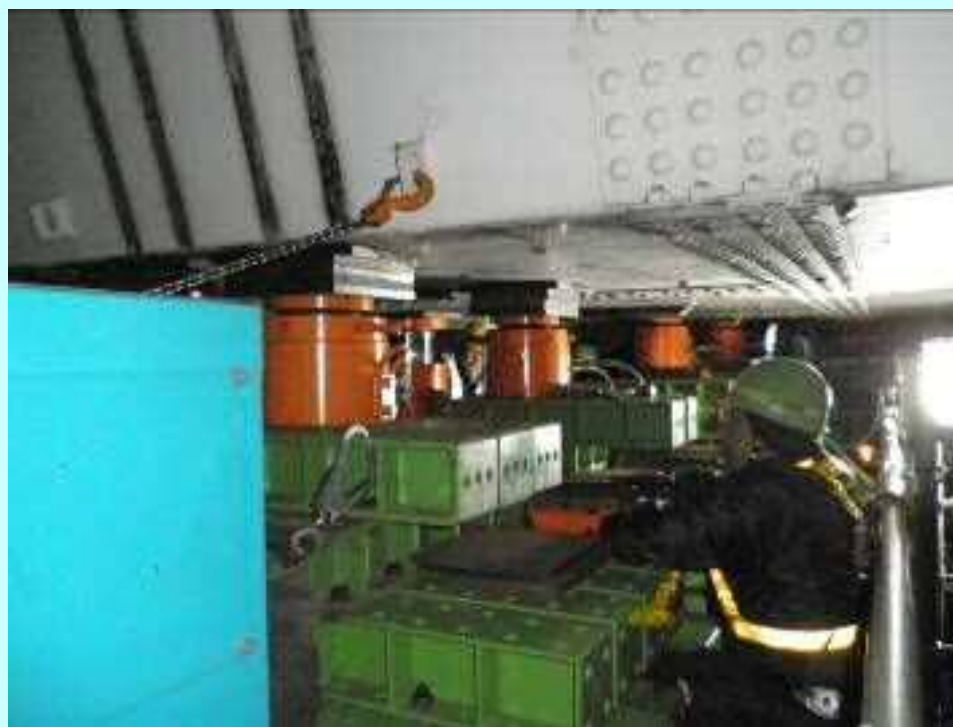
ジャッキアップの状況
