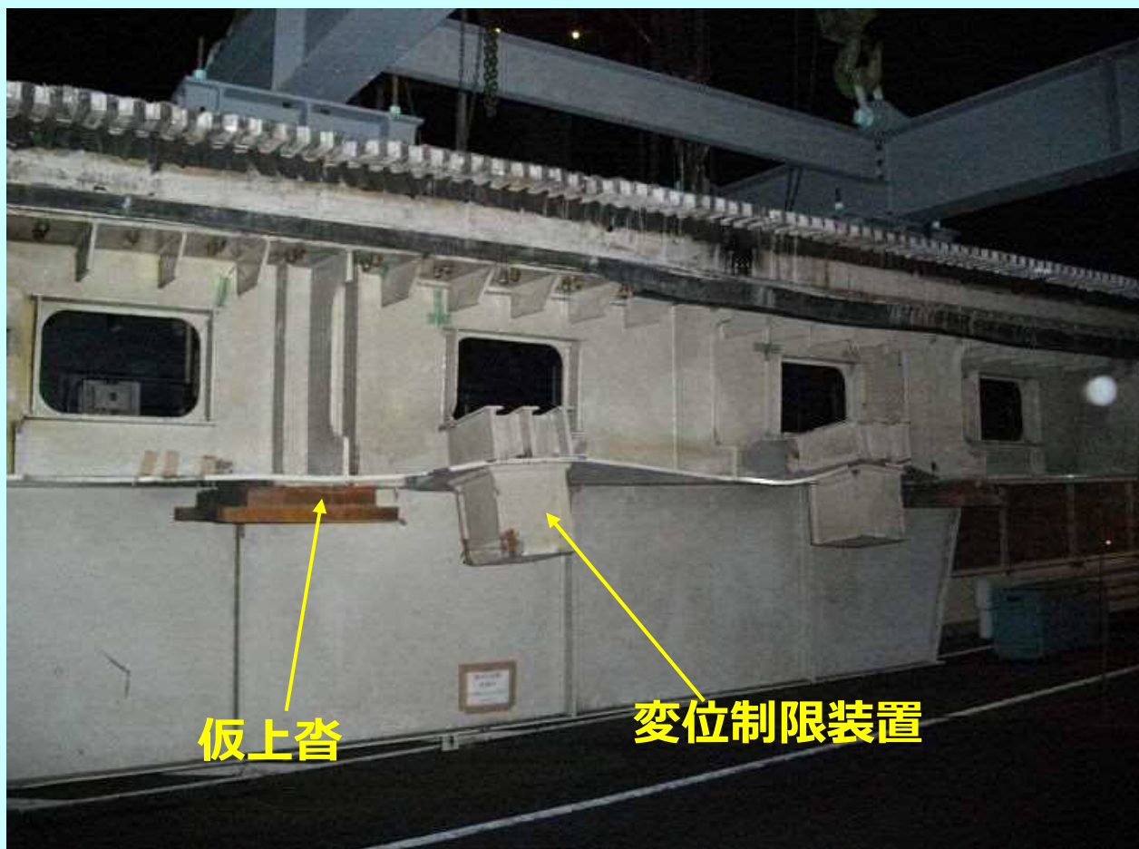
撤去した損傷桁の状況
