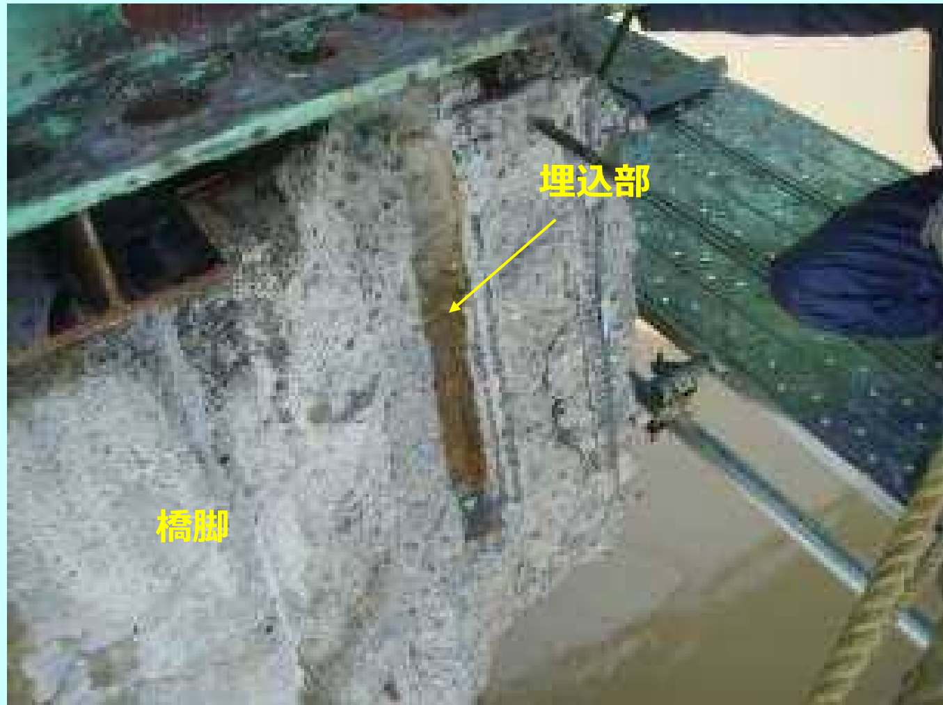
アンカーバー埋込部の破壊状況
