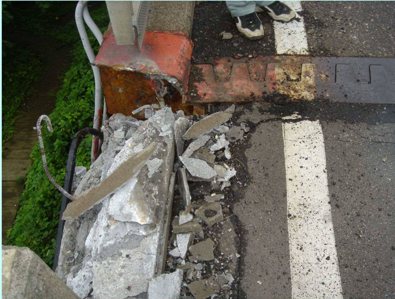
橋面上の損傷状況（伸縮装置部の地覆コンクリート損傷）
