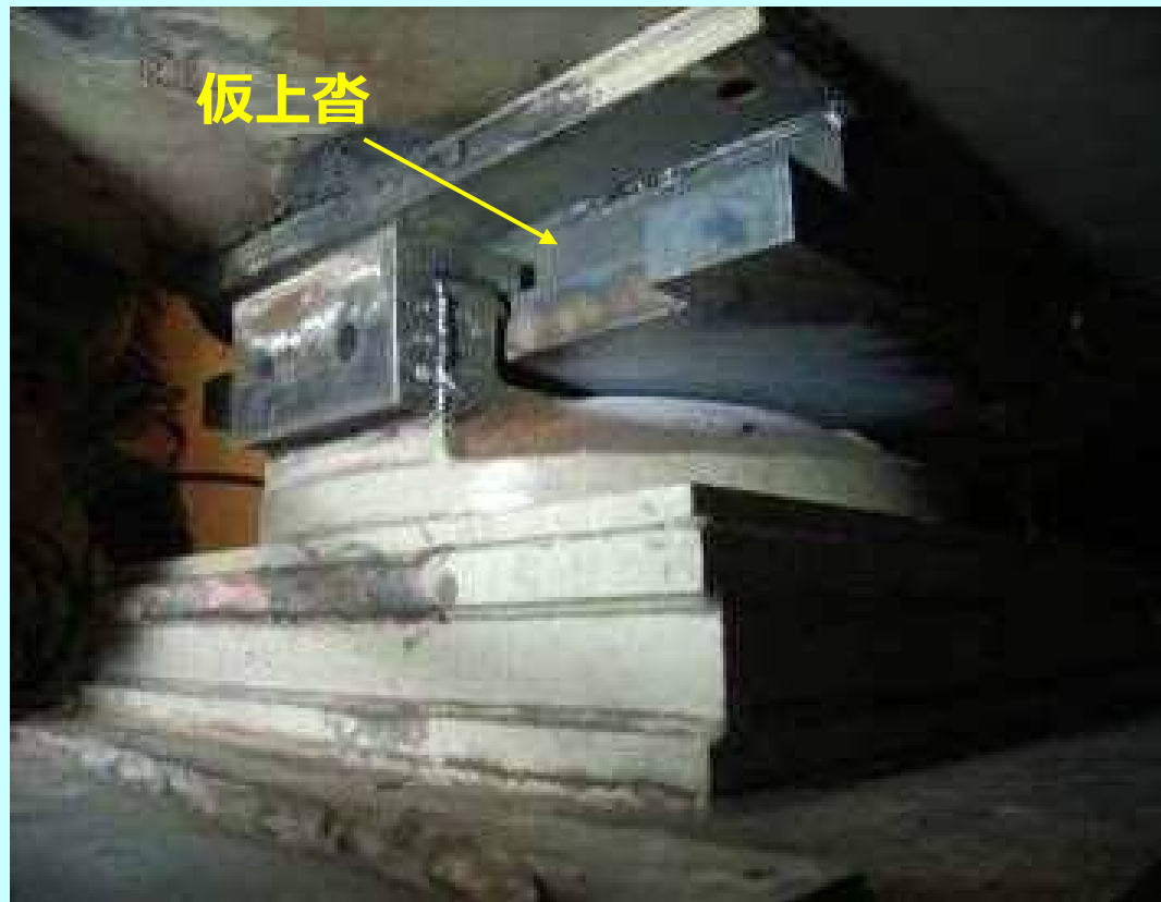
仮上沓の設置状況
