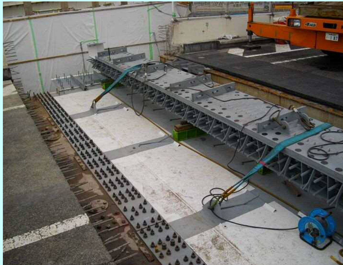
伸縮装置取付の状況
