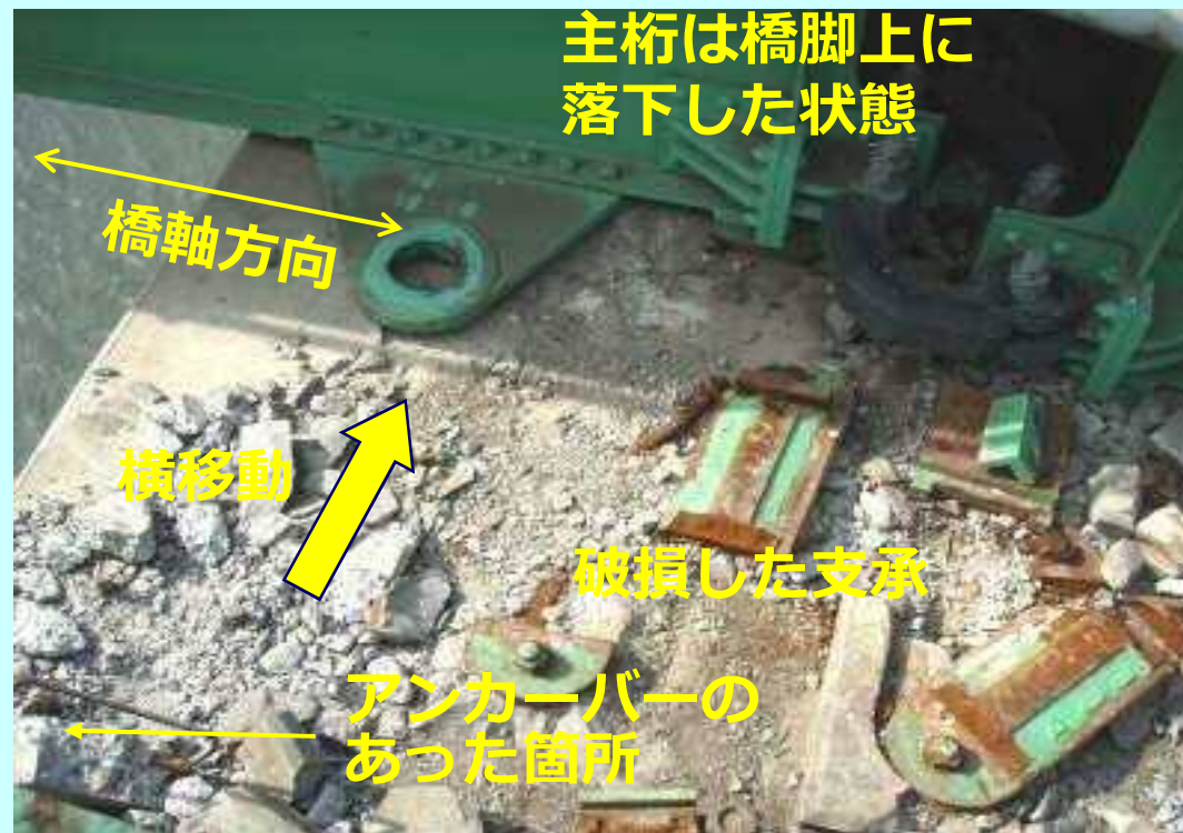
橋脚上の損傷状況
