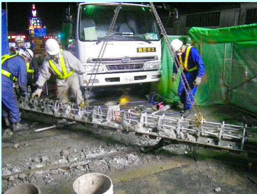
既設伸縮装置の撤去状況
