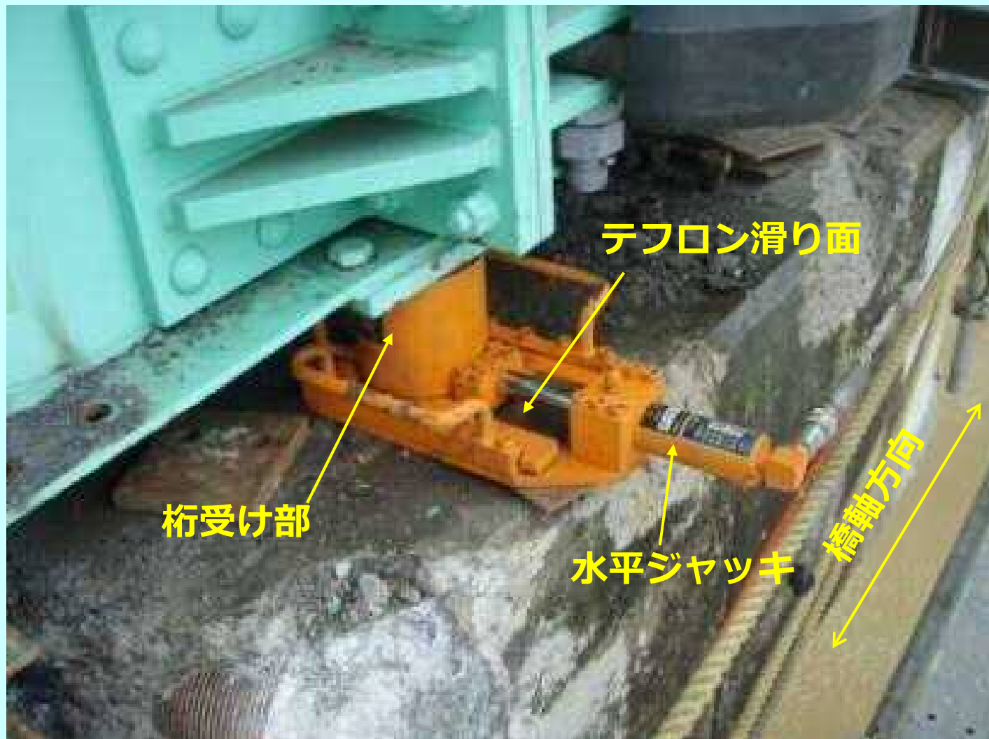
水平ジャッキによる横移動状況
