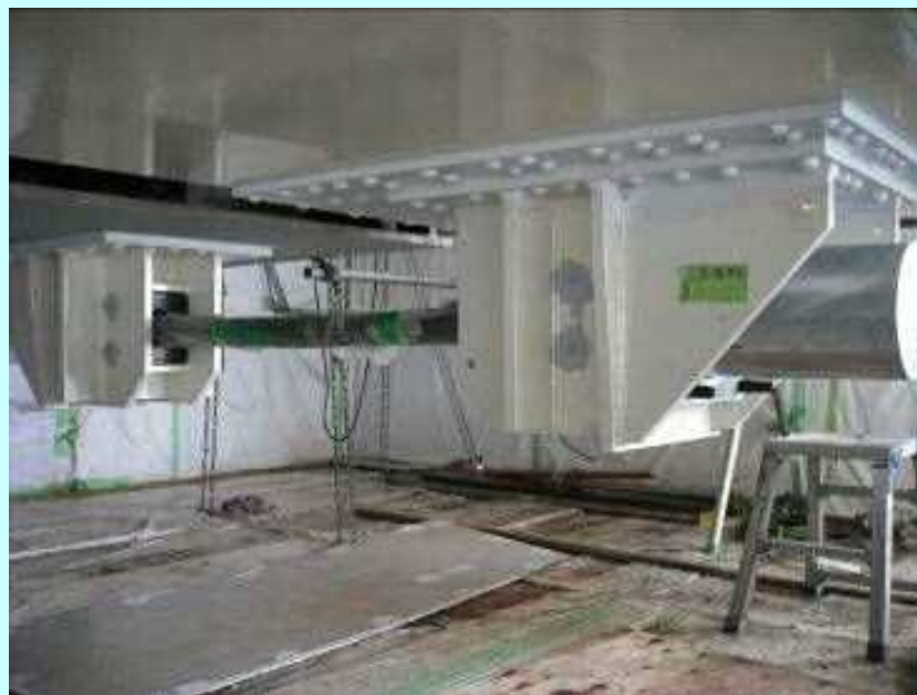
落橋防止装置設置完了
