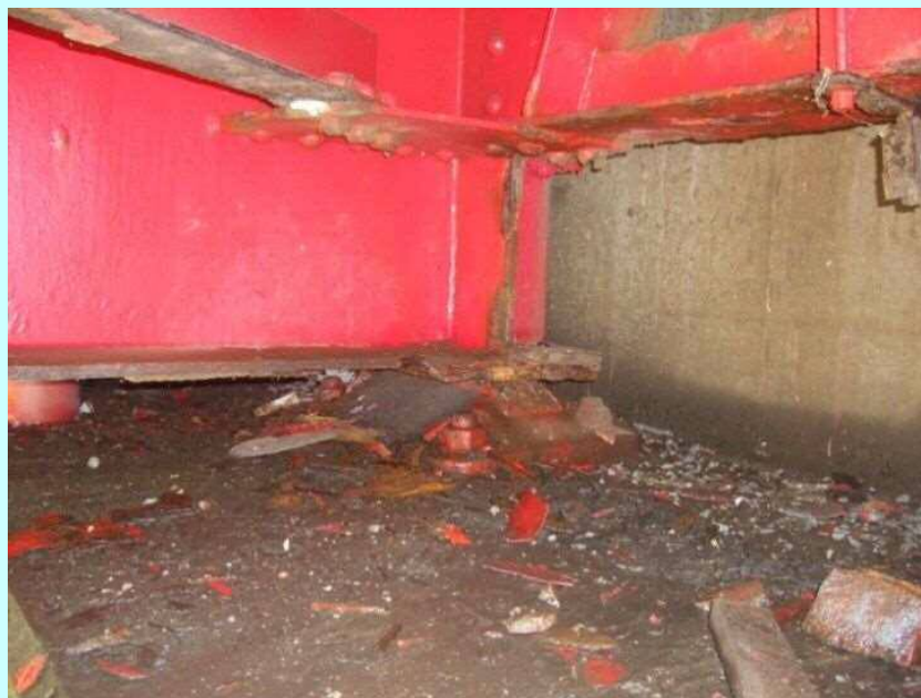
支承の破損、主桁下フランジ 腐食の状況
