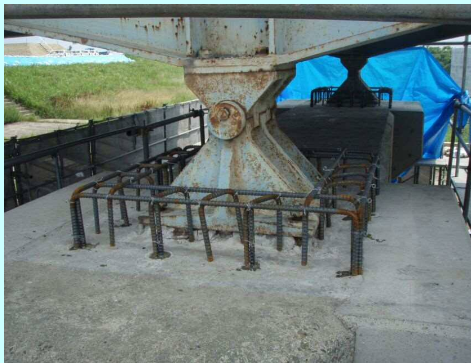
差し筋配筋後の状況
