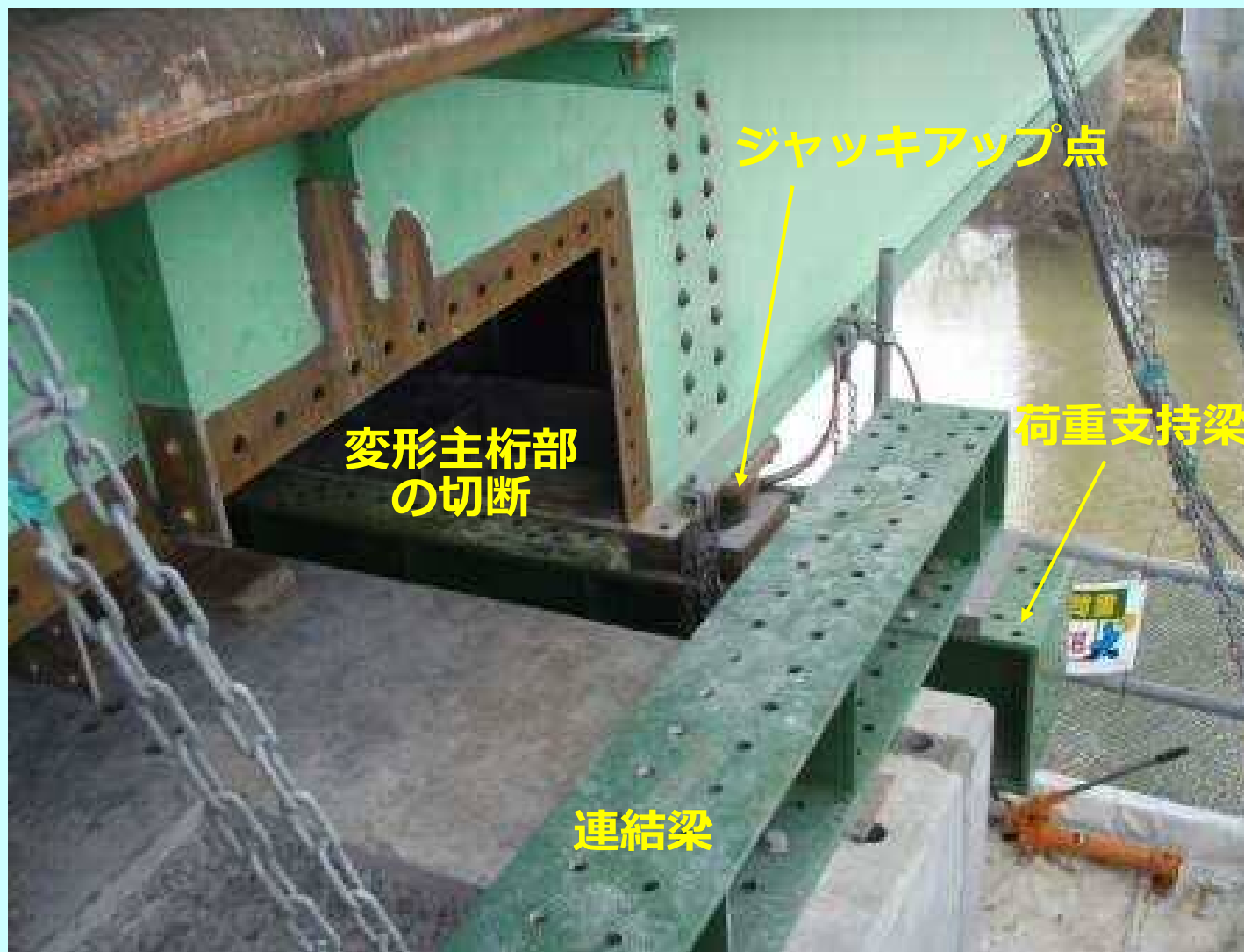
鞍掛け方式による仮受け状況
