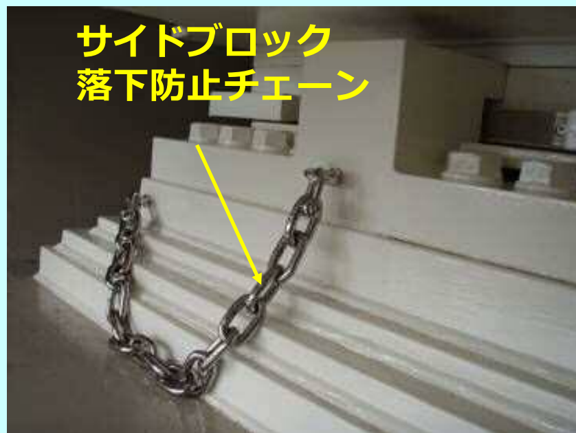
ゴム支承設置完了
