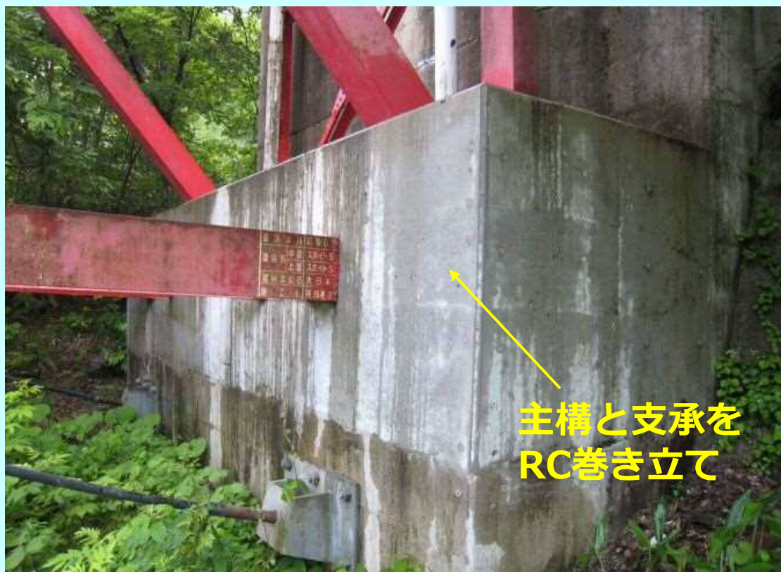
支点部の応急対策の状況
