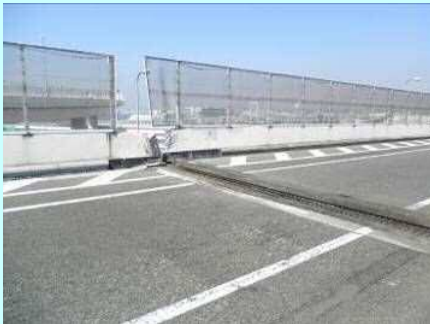
伸縮装置の損傷、路面の段差
