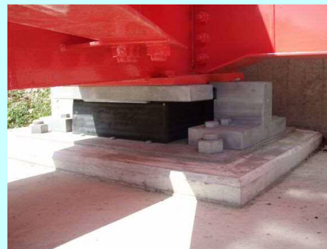
ゴム支承への取替え
