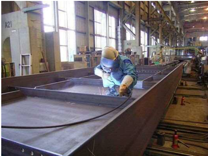
補剛材組立溶接
