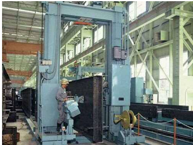
I桁矯正装置
