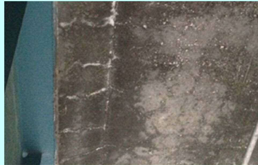
凍結防止剤散布環境下でのASRによる劣化事例
