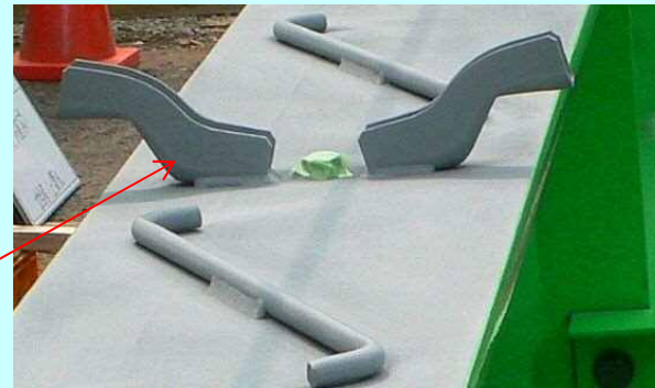
かぶりを確保する支保工取付け用吊金具の例
