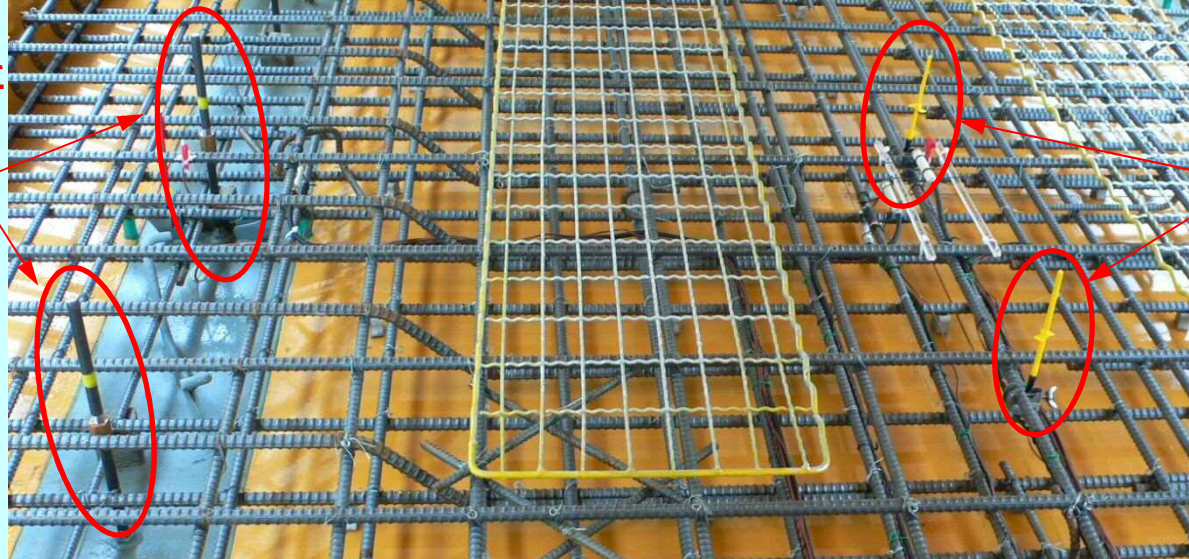
定規用鉄筋(検測棒)等の施工事例
