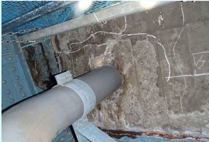
排水柵周辺からの漏水
