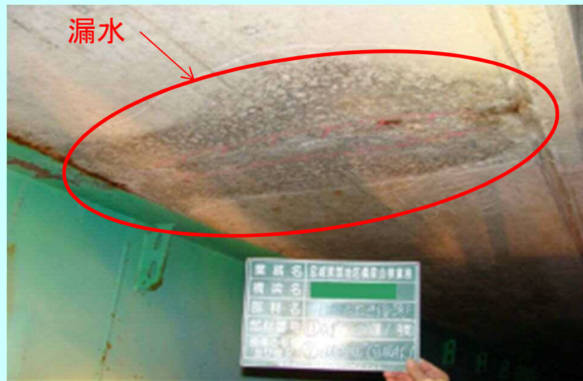
床版打継目からの漏水
