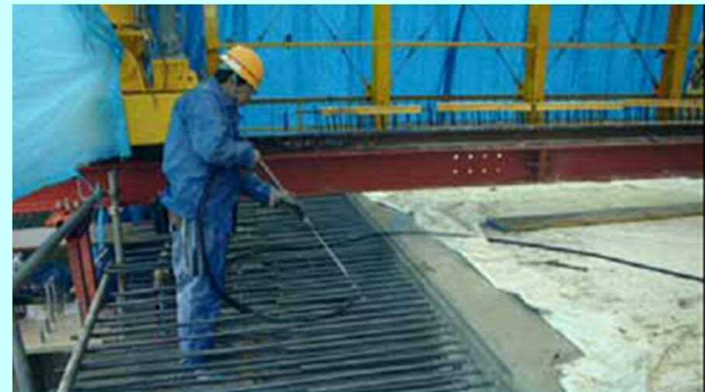
高圧水によるレイトンス処理状況
