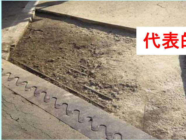
凍害による劣化事例
