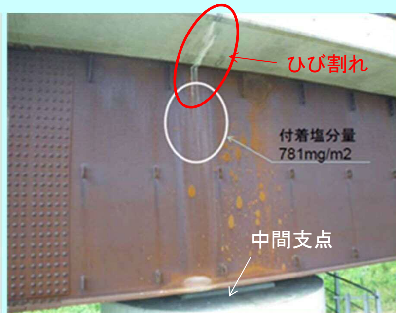
連続桁の中間支点上ひび割れ
