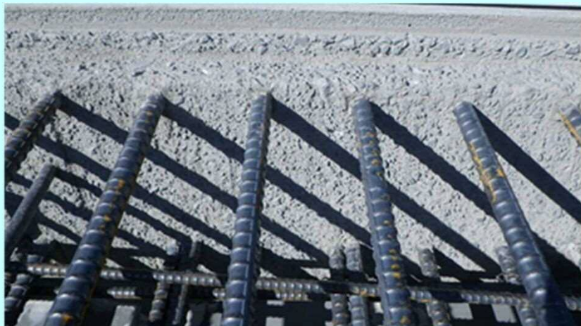
打継目処理後の状況
