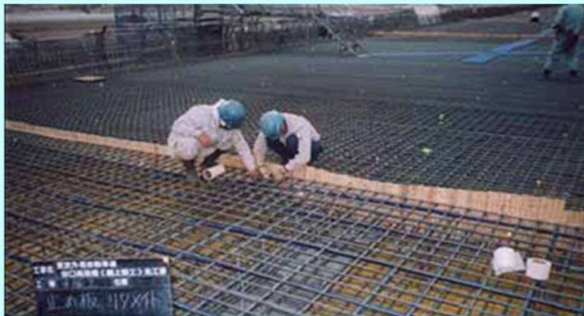
せき板設置・凝結遅延剤塗布状況
