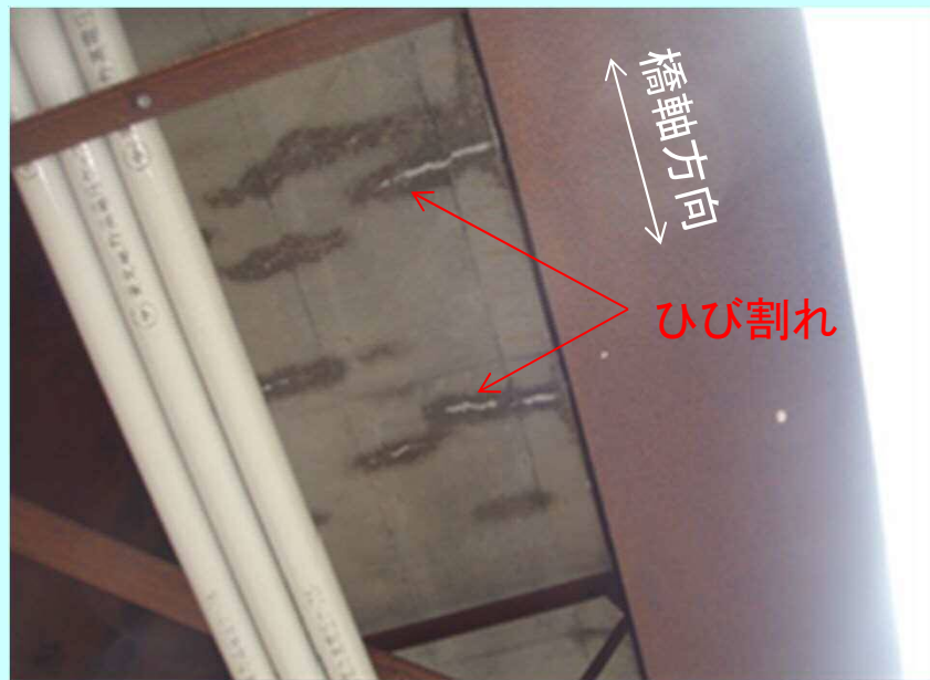
主桁の拘束による乾燥収縮ひび割れ
