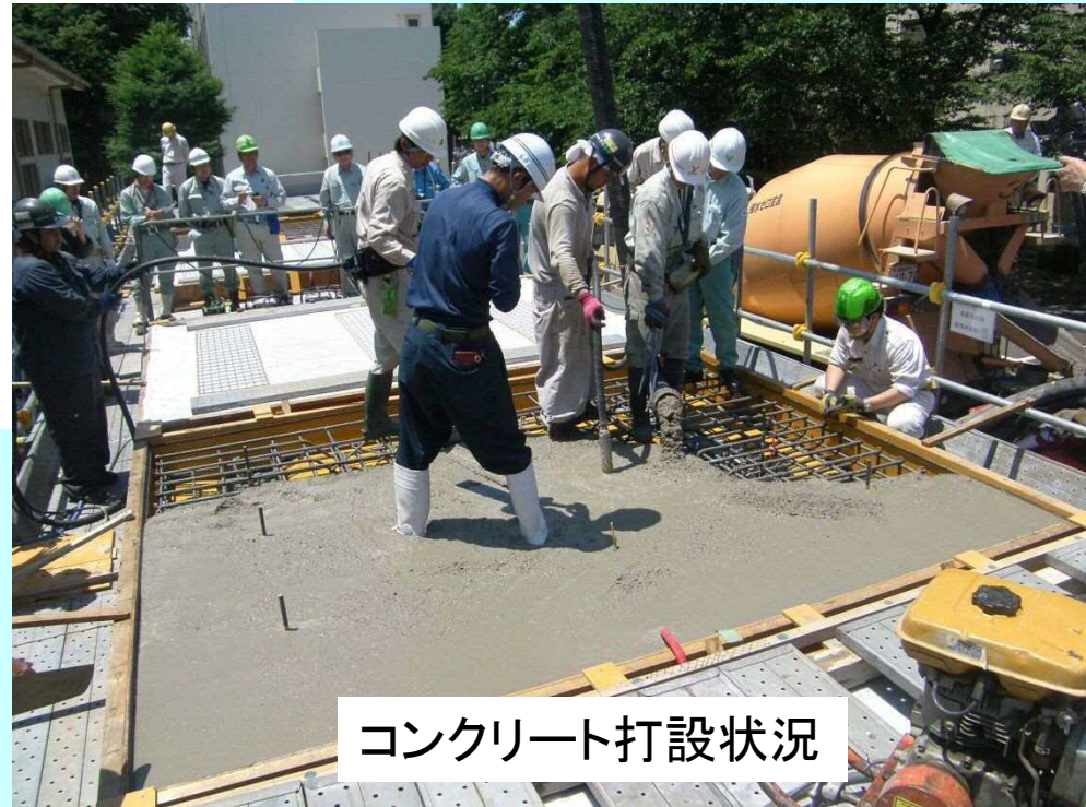
コンクリート打設状況
