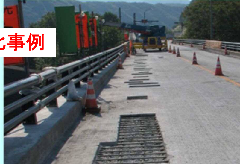
走行車両の軌跡に沿った劣化
