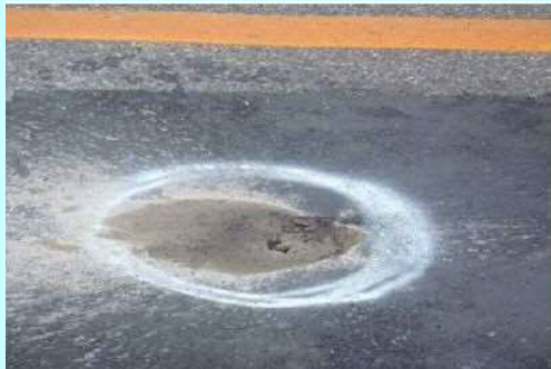
凍害による劣化事例
