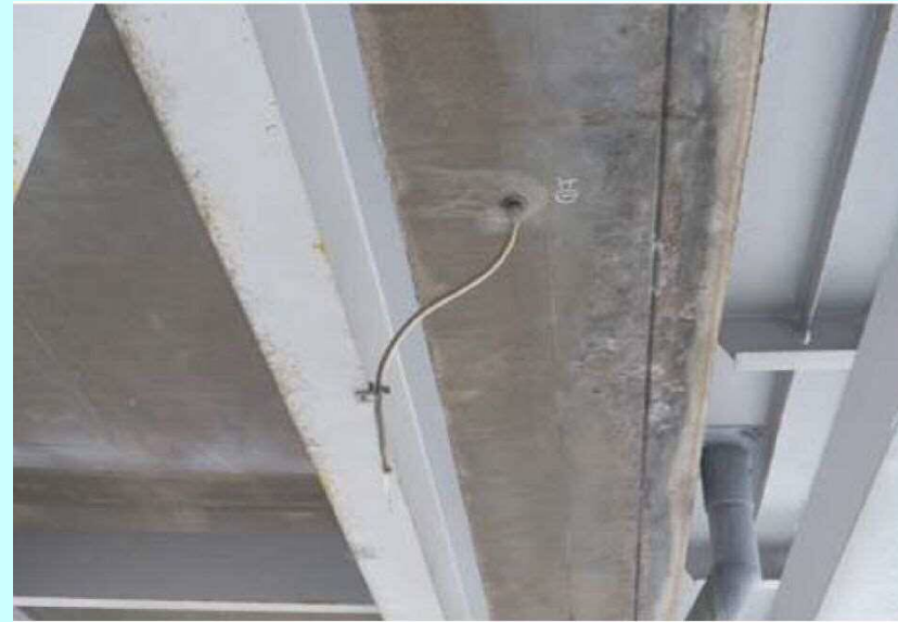
スラブドレン周辺の漏水または伝い水
