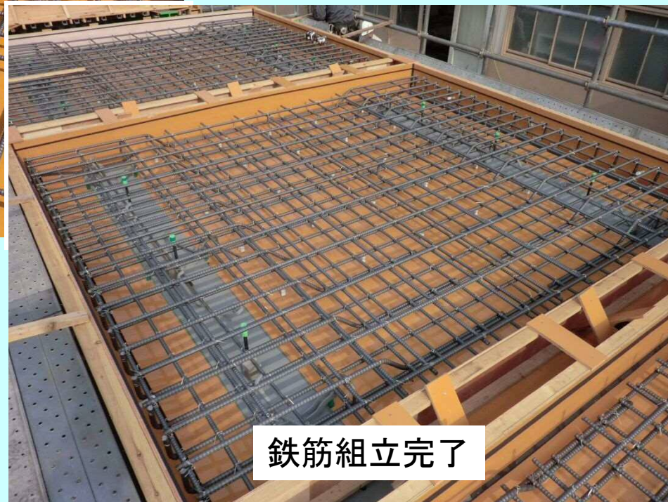
鉄筋組立状況
