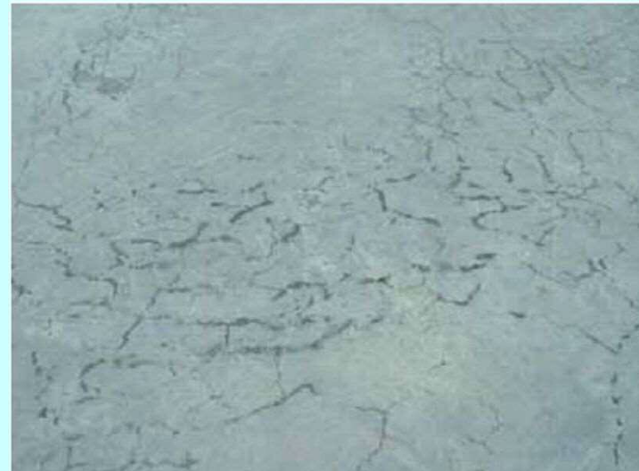
プラスチック収縮ひび割れ
