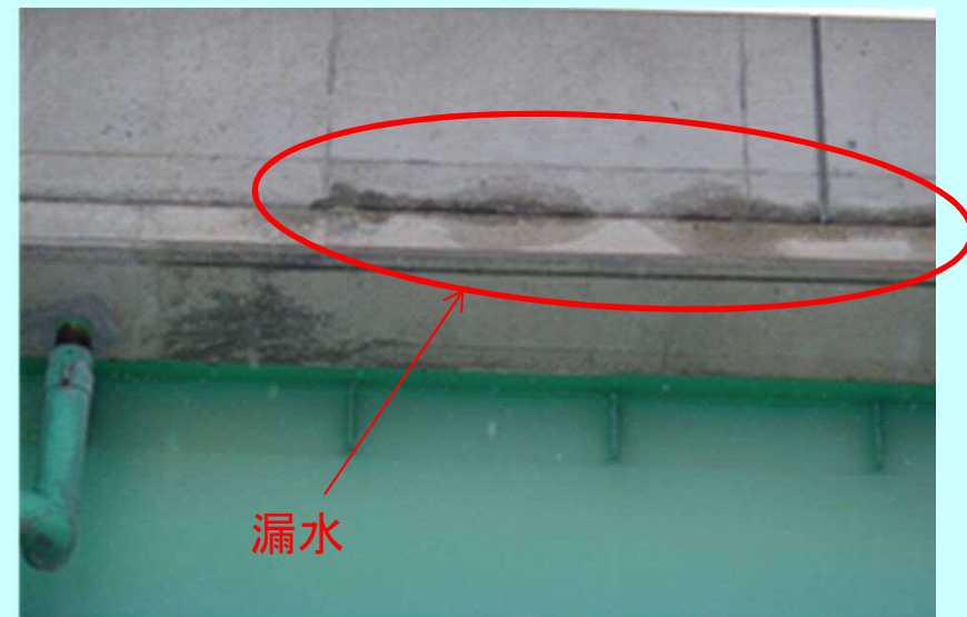
床版と地覆の打継目からの漏水
