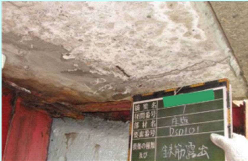
凍結防止剤散布環境下での塩害事例
