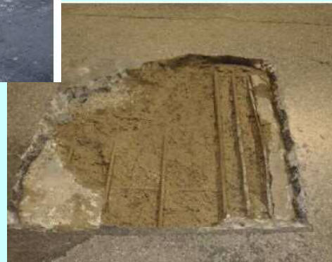
舗装のポットホールと床版上面の砂利化
