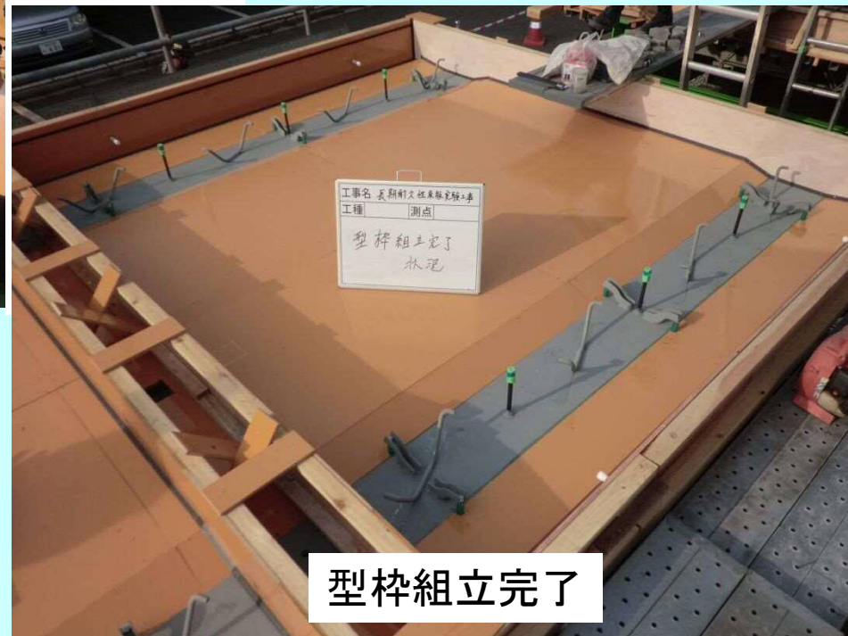
型枠組立状況
