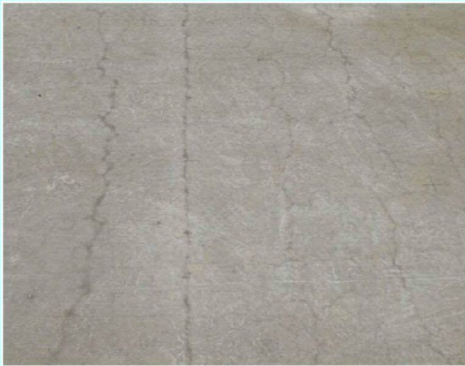
沈下ひび割れ
