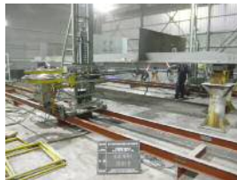
自動機による施工状況
