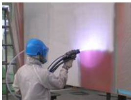
溶射技能士による施工状況
