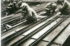
昭和初期の工場溶接風景
