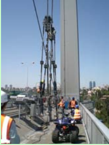
ロングハンガー用プレート交換状況
