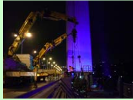
ケーブルクランプの取付け(夜間)
