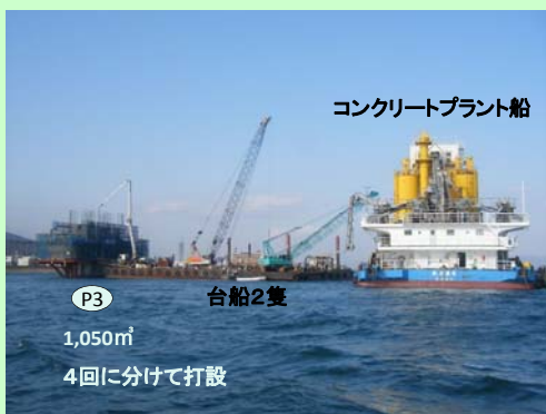
橋脚コンクリート打設
