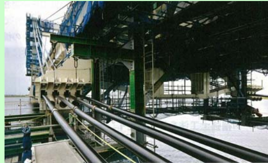
水平ケーブル架設完了
