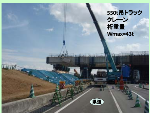
県道上架設 (P1~P2側径間)
