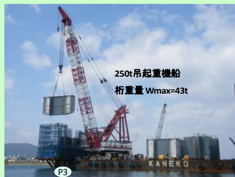
主塔基部架設
