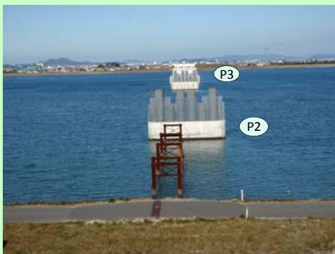
着工前(P1より)
