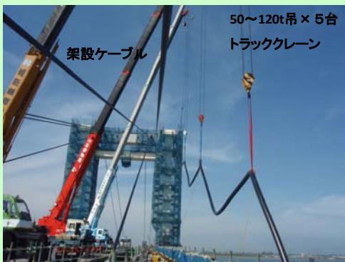
斜ケーブル相吊り架設
