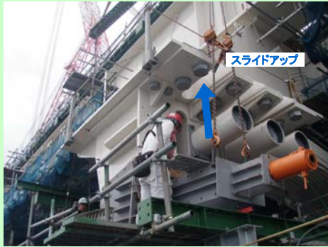
水平ケーブル引込み→スライドアップ
