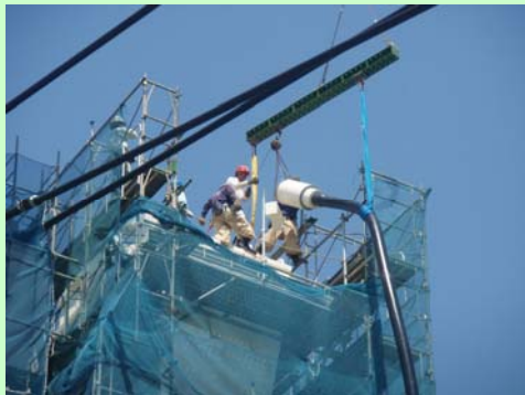
斜ケーブル主塔側吊上げ
