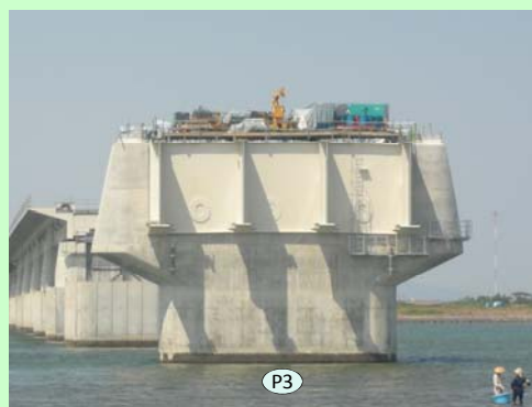
橋脚剛結部完成
