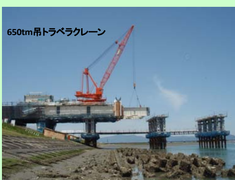
河川上ベント架設 (P1~P2側径間)
