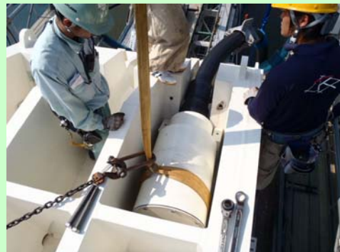
主塔側(塔頂サドル)定着
