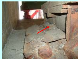
カバープレートが腐食で損失し、ローラーが露出している。
