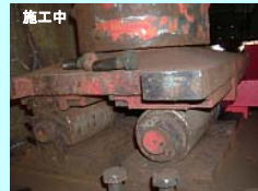
支承のサイドブロックを解体し、ローラー部分を清掃
