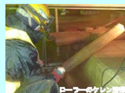
ローラーのケレン整備
