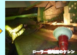
ローラー撤去後のケレン
