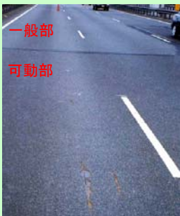
デッキ貫通き裂の様子
