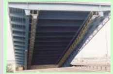
損傷があった可動部
