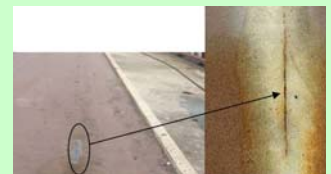
デッキ貫通き裂の様子
