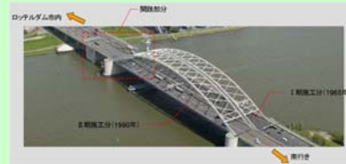
Van Brieneoord Bridge
