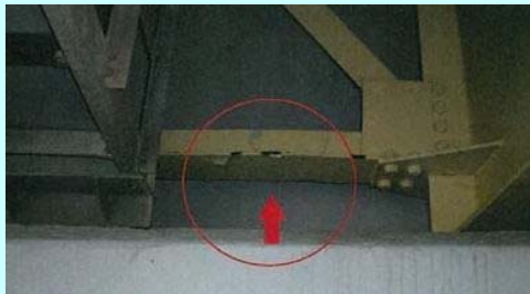
鋼橋に不慣れな施工業者が、端対傾構の下弦材をジャッキアップして、座屈させた事例
