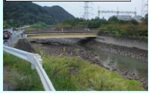
九州電力葦北発電所・葦陽橋
