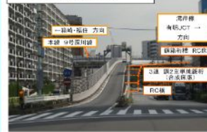
・ 9号深川線枝川ランプ
