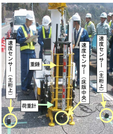
写真-7 衝撃加振によるたわみ計測機 (I I S)
