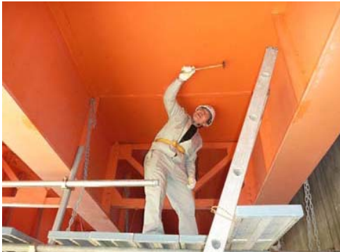
写真-3 ハンマによるたたき試験
