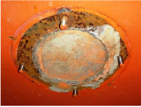
写真-2 点検用ハッチ（蓋を取り除いた状態）
