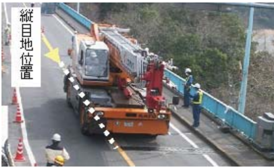
写真-10 荷重車 (50t 吊ラフテレーンクレーン)
