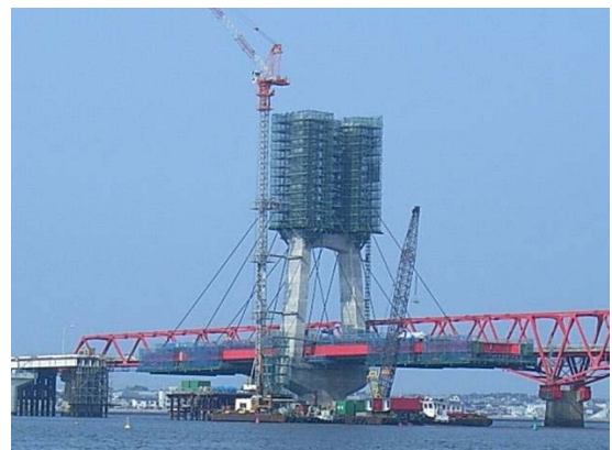
写真-4 バランシング架設状況
