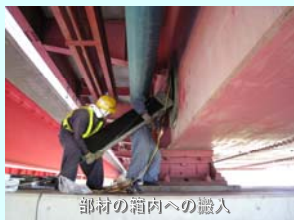
部材の箱内への搬入
