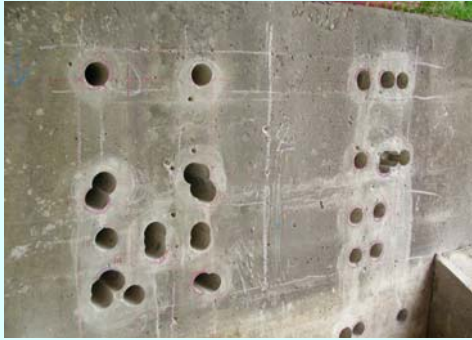
孔埋め作業も発生する
