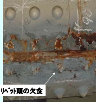
腐食リベットの取替えによる水の浸入
