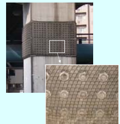
落下防止ネットの取付例
