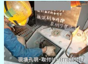
現場孔明・取付け・HTB締付け
