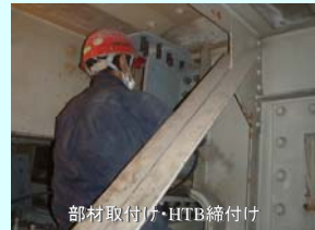
部材取付け・HTB締付け
