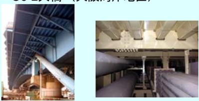
橋梁形式: 3径間連続鋼床版箱桁ゲルバー橋
