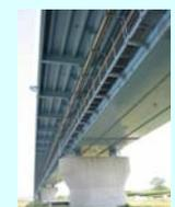
橋梁形式: 3径間連続鋼床版箱桁橋×3連
