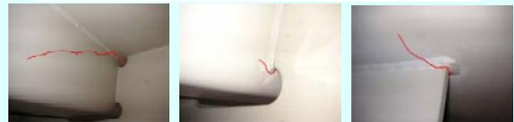
①デッキとUリブ溶接部 ②Uリブと横リブ交差部 ③垂直補剛材上端部
