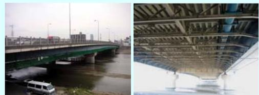
橋梁形式: 3径間連続鋼床版箱桁橋
