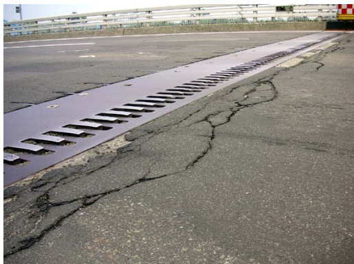
写真-9 伸縮装置の損傷
