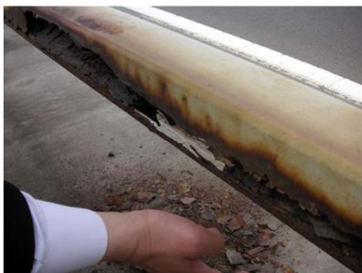
写真-10 高欄の腐食
