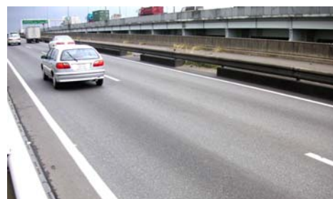
写真-8 ガードレールの設置による圧迫感
