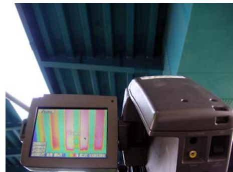
写真-18 サーモレーサによる調査
