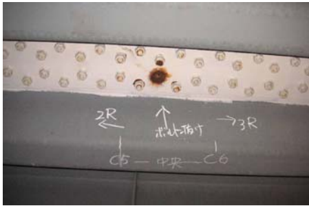
写真-14 デッキプレート添接部の高力ボルトの脱落
