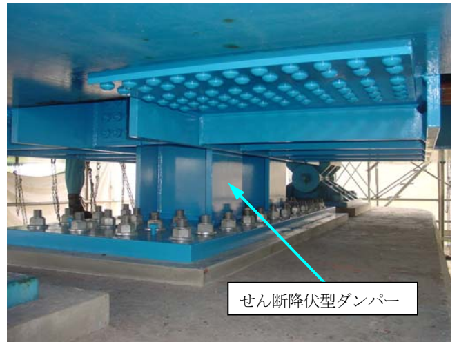
写真-6 せん断降伏型ダンパーの設置例（桁橋）
