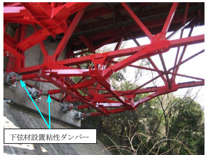
写真-4 粘性ダンパーの設置例（鋼上路式トラス橋）
