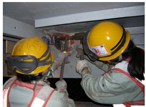
写真-18 ドリル穿孔後のリベット抜き作業状況
