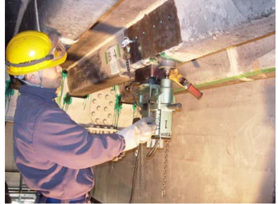
写真-26 鋼床版トラフリブへの大口径孔明け （上向き施工のためレバーブロックにより マグネット反力を補助している）
