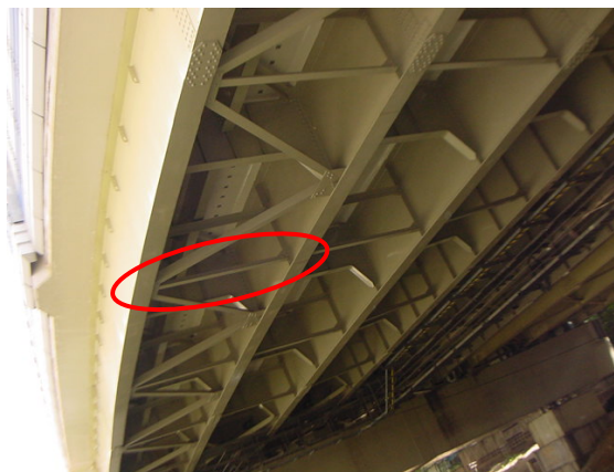
写真-11 現況写真
