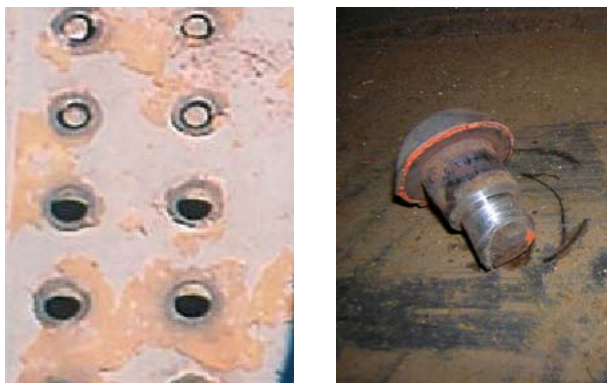
写真-17 リベット撤去後の状況と撤去したリベット
