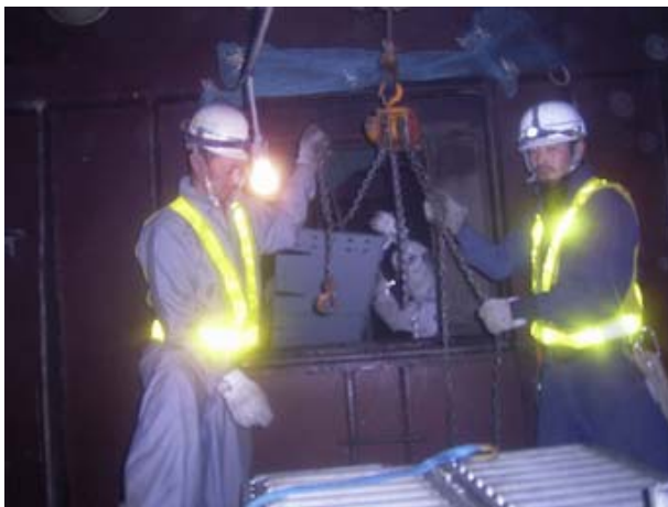
写真-12 部材搬入状況(1)
