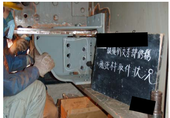
写真-4 作業状況
