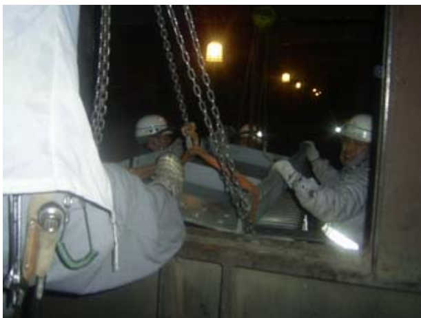
写真-13 部材搬入状況(2)
