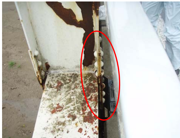
写真-8 現況写真
