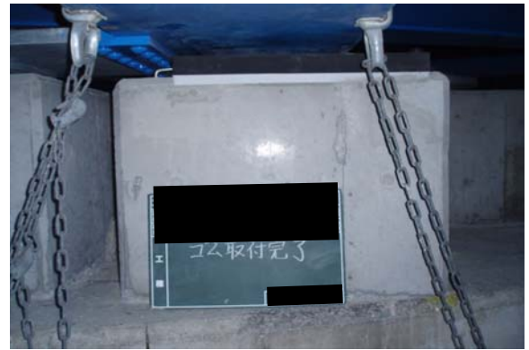
写真-7 施工完了状態
