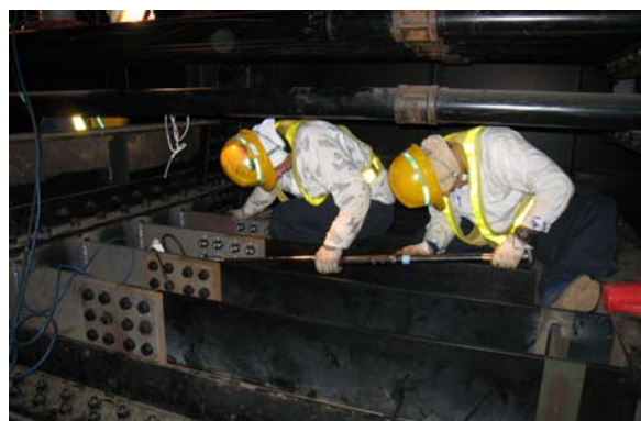
写真-32 ボルト締め付け状況
