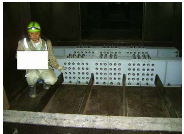
写真-15 取付完了(内部)
