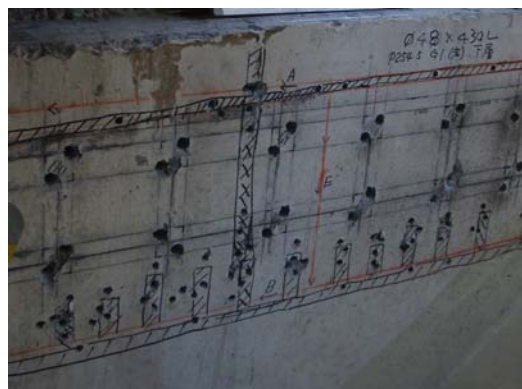
写真-20 パイロットホールによる鉄筋確認
