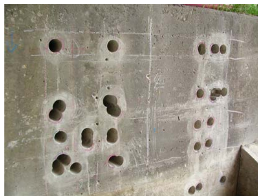
写真-22 コア穿孔後状況 (鉄筋干渉による再穿孔跡)
