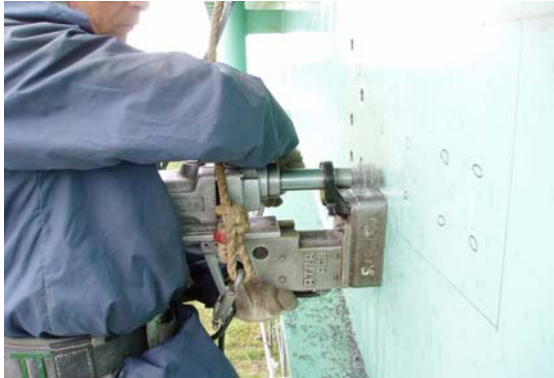
写真-24 ウェブ面の孔明け
