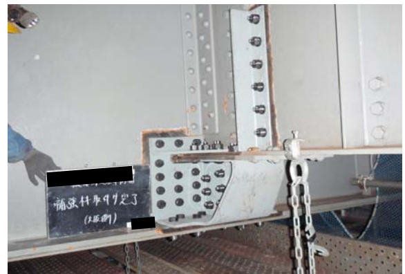
写真-5 補強完了
