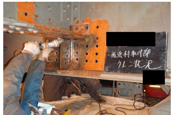
写真-3 作業状況
