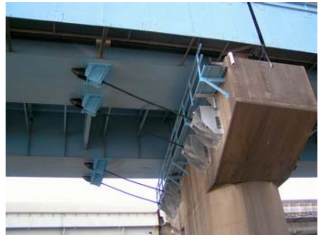
写真-14 取付完了(外観)
