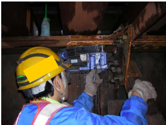
写真-25 狭隘部の孔明け（小型ドリル使用）
