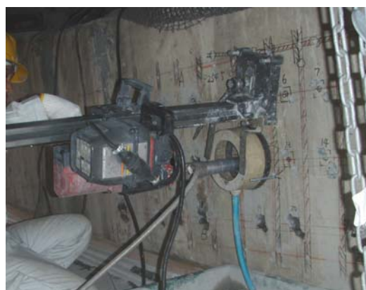
写真-21 ダイヤモンドコアドリル穿孔状況
