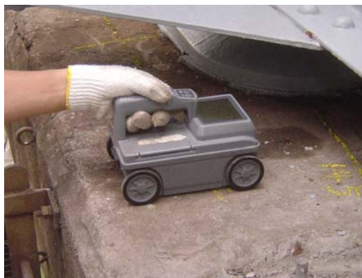
写真-19 電磁波レーダによる鉄筋探査
