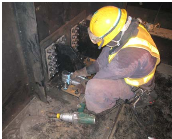
写真-30 ボルト締め付け状況
