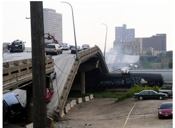
写真-2 ミネソタの落橋
