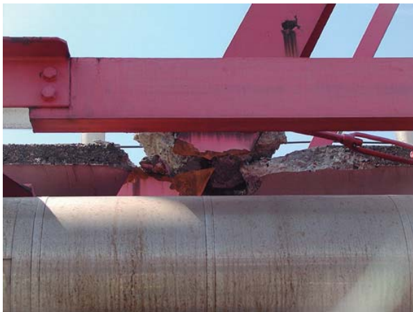
写真-1 木曽川大橋の斜材破断
