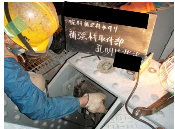
写真-27 トラス格点部の孔明け （小型ドリル使用）
