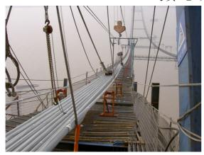
重量 12.2kg/m と非常に重いことから、これまで日本で多く採用してきたキャットウォークロープを空中に直接引き出すフリーハング工法を採用するとウィンチ必要能力が大きくなる。そこで、予め空中に設置したサスペンダー上を引き出すことによりロープ自重の影響を低減させる、サスペンダー方式を採用した。この方式は中国江陰大橋(中央径間1,385m)においても採用されており、中国では一般的な方法のようである。
