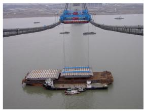
もすべてリフティングガントリー上に設置されたオペレータ室内から運転ができる仕組みとなっている。
