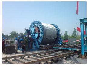
予め工場にて長さ約2,600mの素線127本を東ねてソケティングし、これをリールに巻き取ったもので、総重量は約60ton程度となる。これを一つずつトレーラーにて現場に搬入し、搬入された PWS はストックヤードに一時保管された。
