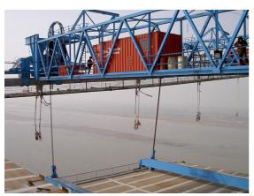
ているマルチストランドジャッキを装備したストランドジャッキ方式であり、イギリスより技術導入を行った。 ディーゼルエンジンを備えているために独立しており、また、リフティングガントリー自身の移動にも油圧ジャッキが用いられ、単独に運転が行なうことが出来た。なお、操作
