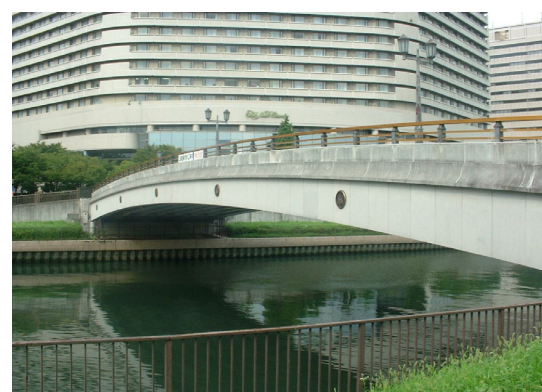
写真-2 大阪城新橋（1983年）
