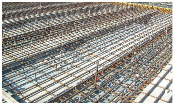
写真-8 ロビンソンタイプの例 (補強材をコンクリート製としたタイプ)
