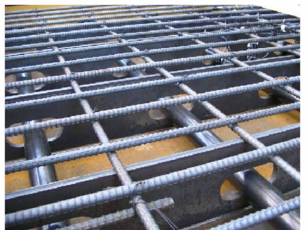
(b) ずれ止め孔内に鋼管を配置した例
