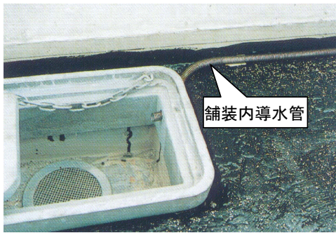
図-7 舗装内導水管
