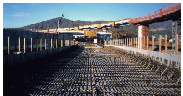
写真-5 形鋼タイプの例
