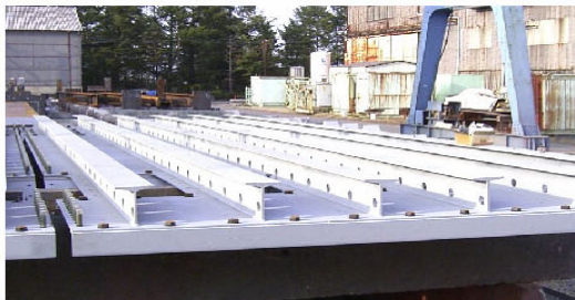
(c) I 形鋼を T 形に切断して使用した例
