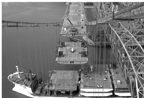
写真-5 桁の架設状況
